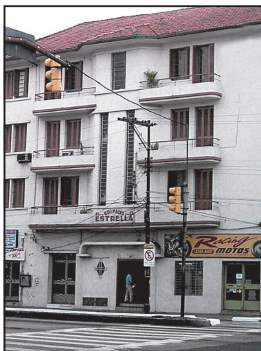
Figura 6.30 Foto de edificação – Fachada. Fonte: O autor
