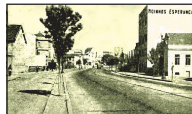
Figura 4.10 Início do processo de pavimentação tomada em sentido.
