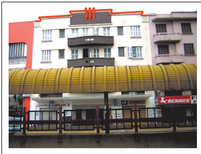
Figura 6.106 Platibanda escalonada. Fonte: O autor
