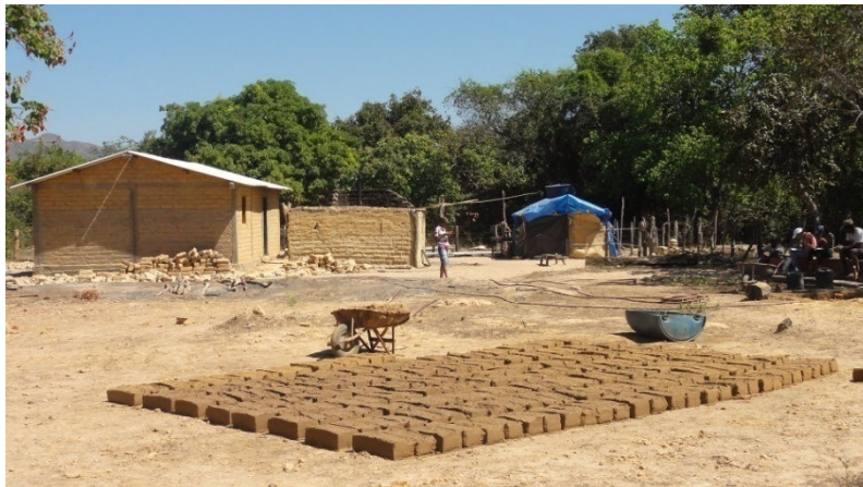
Foto. Construção de casas em adobe na Maiadinha Autor: Sandra Echeverry, 2013
