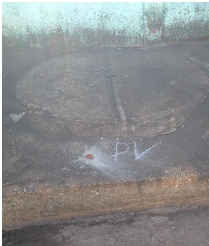
FIGURA 37 – Marcações para rede de esgotamento sanitário e fossas ao longo dos passeios públicos In: Autor, 2014
