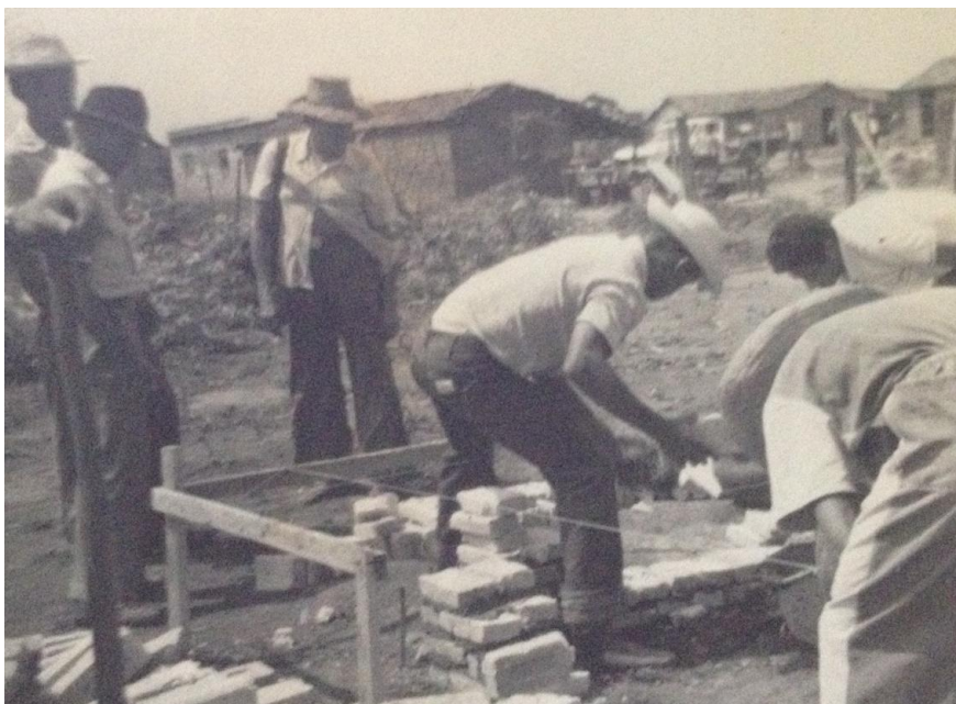
FIGURA 21 - Mutirão de moradores para a construção da Escola Municipal In: Acervo Pessoal - Geralda Santa Barbara
