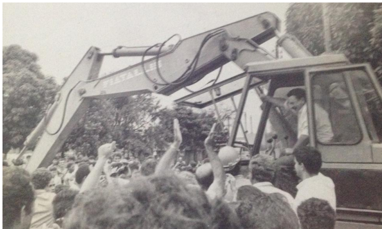
FIGURA 23 – Lançamento das Obras de Pavimentação In: Geralda Santa Bárbara - Associação de Moradores (1993)
