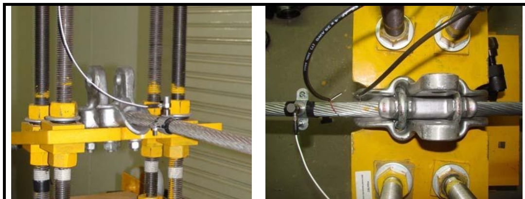
Figura 0.8 – Montagem cabo/grampo vista de frente e de topo [8].
