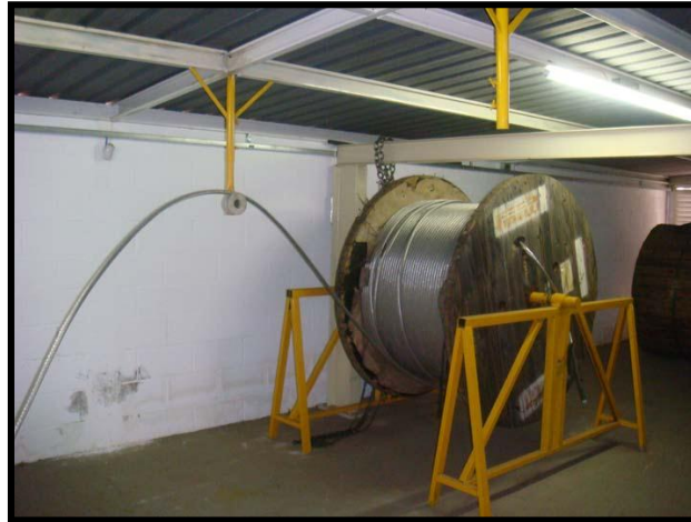
Figura 0.17 – Retirada do cabo condutor da bobina.
