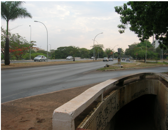
Figura 76 - Parte externa do acesso da passagem subterrânea da Asa Sul
