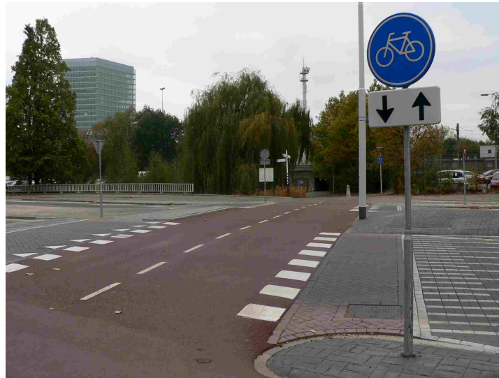
Figura 62 – Exemplo de travessia de cruzamento de via com continuidade da ciclovia sobre platô (Holanda)
