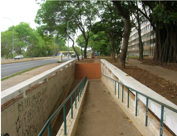
Figura 74 – Acesso da passagem na Asa Norte, com rampa para deficiente
