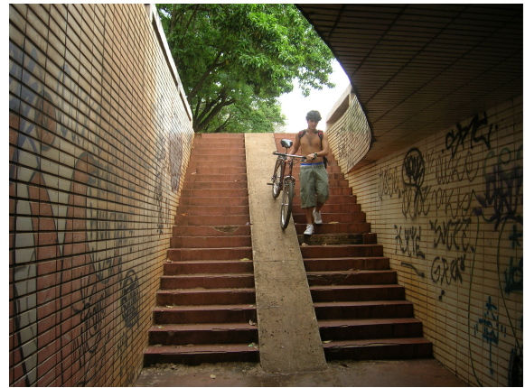
Figura 77 - Escada com trecho “rampado” no acesso da passagem subterrânea na Asa Sul
