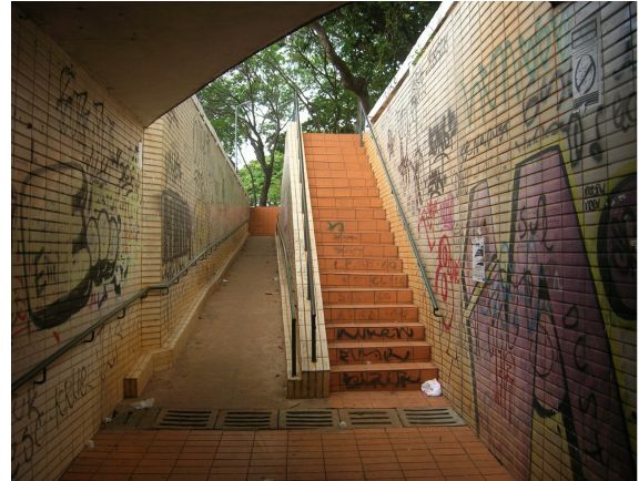
Figura 75 – Acesso da passagem na Asa Norte
