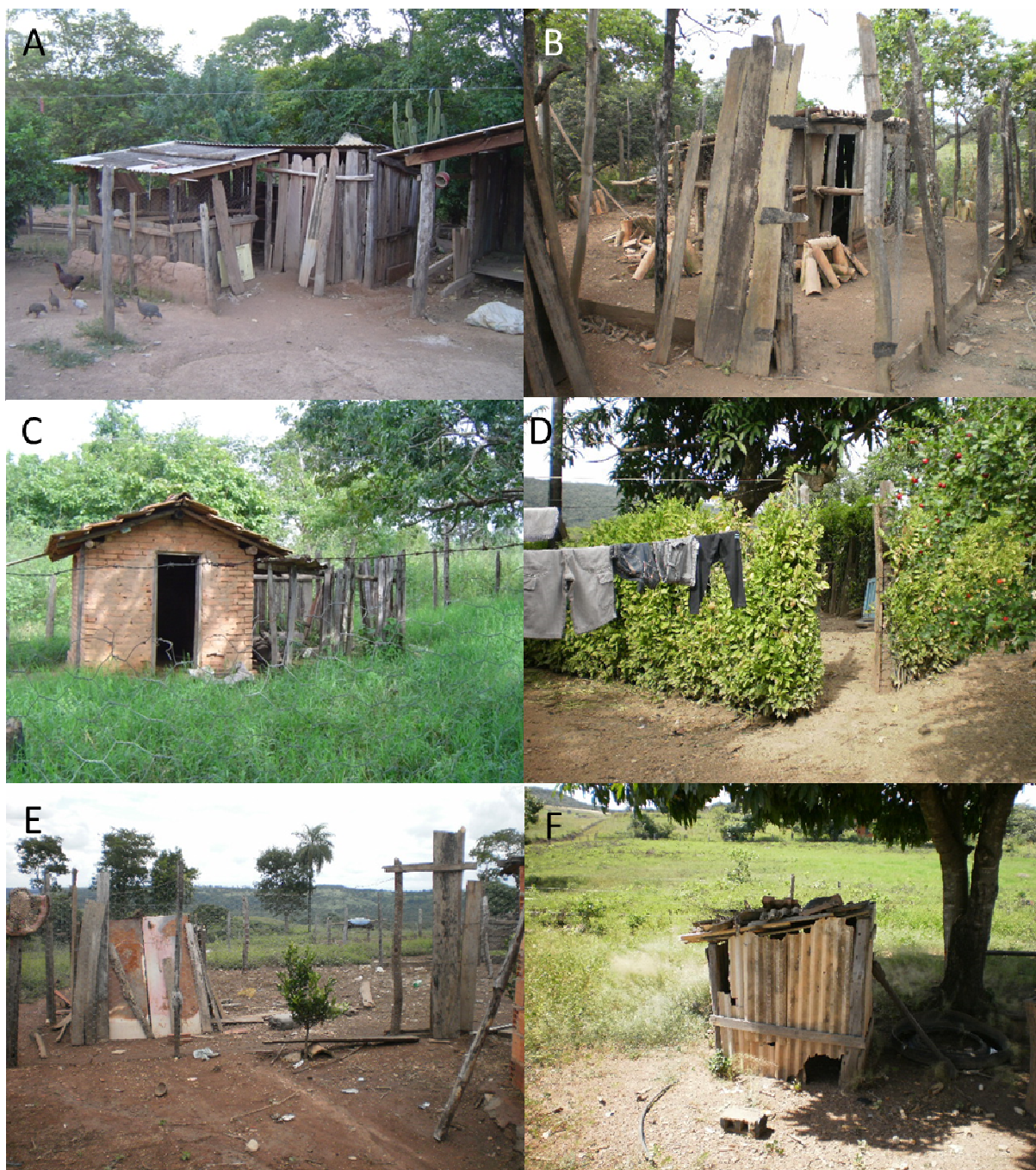
Figura 10. Estrutura dos galinheiros nas localidades de Trombas e Periquito, Posse, Goiás, 2013. A: Galinheiro de madeira com telha de amianto. B: Galinheiro de madeira com telha de cerâmica. C: Galinheiro de alvenaria. D: Galinheiro com cerca vegetal. E: Galinheiro com tela e sem cobertura. F: Galinheiro com telha de amianto.
