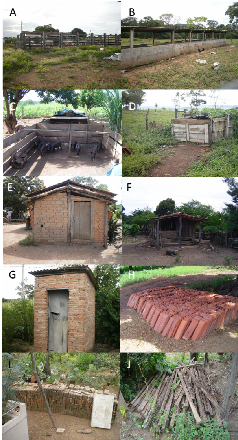
Figura 11. Outros anexos peridomiciliares nas localidades de Trombas e Periquito, Posse, Goiás, 2013. A: Curral com cobertura de telha de cerâmica. B: Chiqueiro de alvenaria com telha de amianto. C: Chiqueiro de madeira sem cobertura. D: Chiqueiro de madeira com cobertura. E: Rancho de adobe. F: Paiol de madeira e telha de cerâmica. G: Banheiro de alvenaria e telha amianto. H: Pilha de telha. I: Pilha de tijolos. J: Entulho de madeira.
