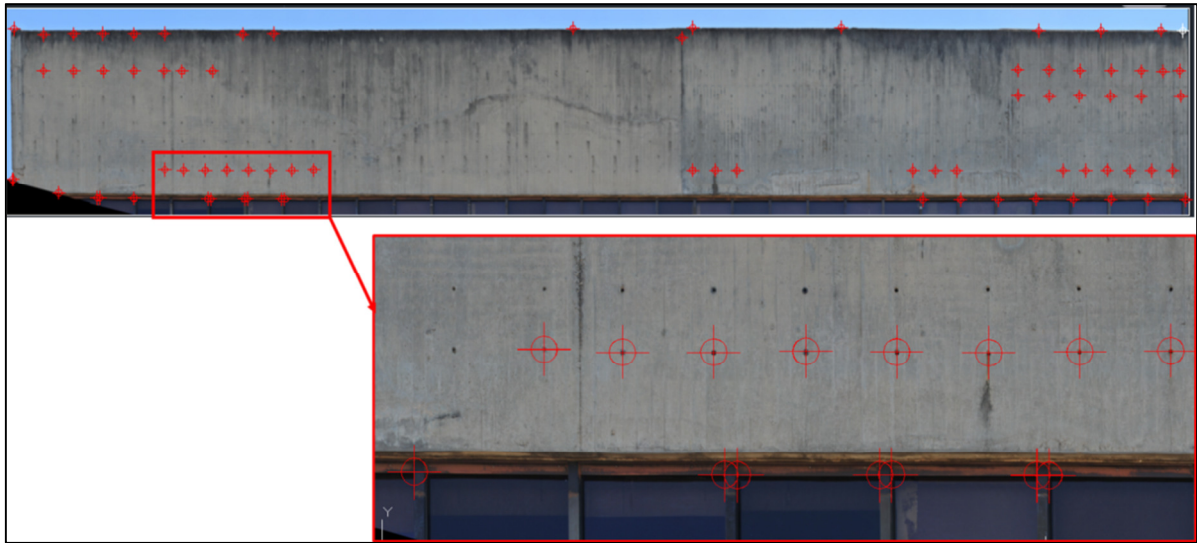
Figura 5. 55 - Pontos de controle marcados na posição 1 da imagem panorâmica da fachada Norte do edifício Anexo IV da Câmara dos Deputados
