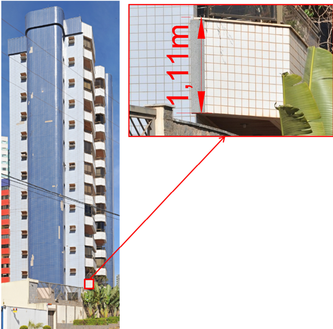
Figura 5. 8 – Escalamento da imagem panorâmica do edifício realizada com o auxílio do AutoCAD 2014
