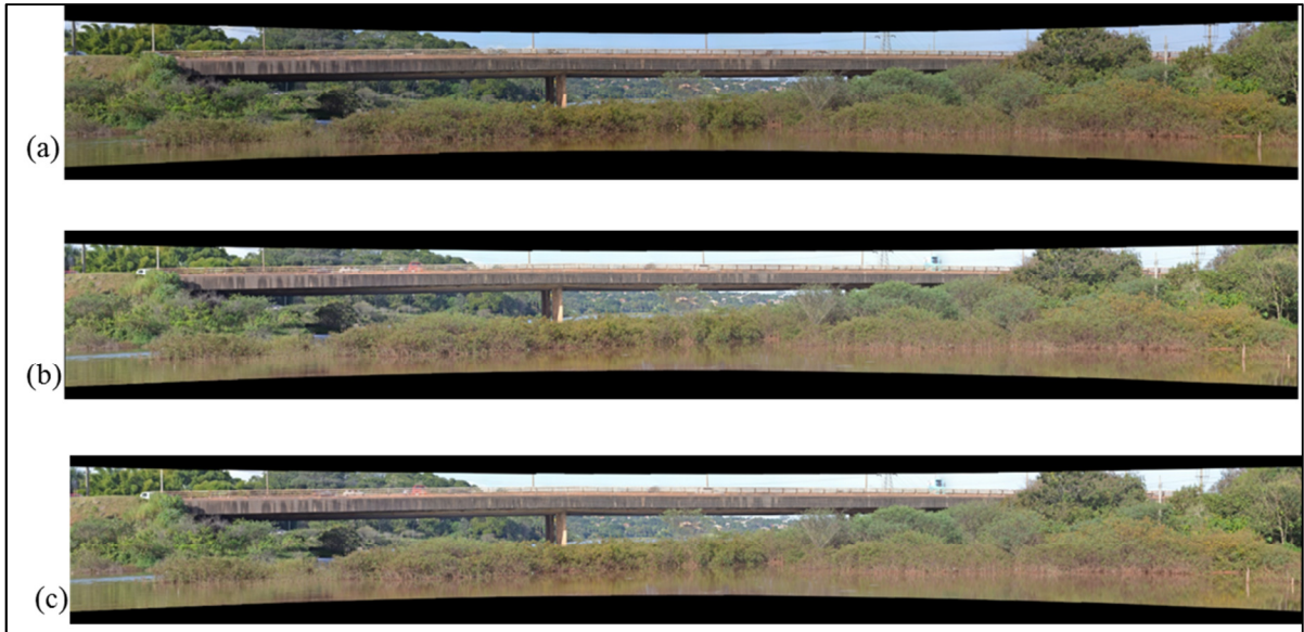
Figura 4.14 – Imagens panorâmicas geradas com diferentes aberturas do diafragma: (a) f/22 ; (b) f/16 e (c) f/11 .
