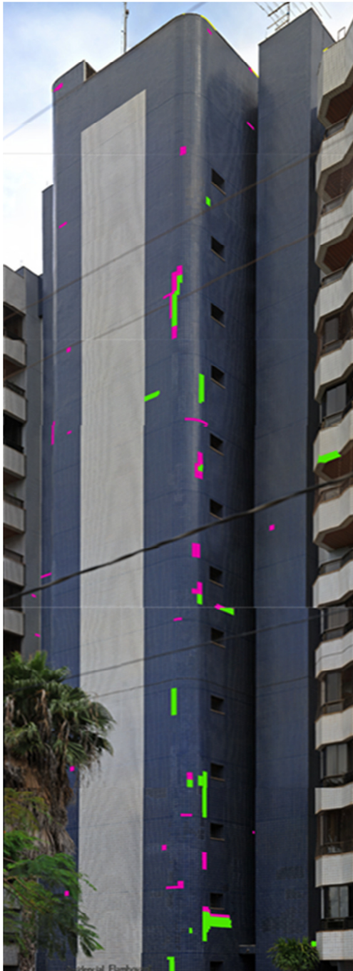
Figura 5. 16 - Mapeamento das manifestações patológicas identificadas na fachada A (Posição Lateral)
