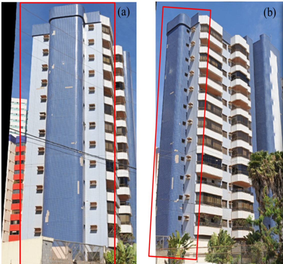
Figura 5. 4 - Fachada B do edifício: (a) Posição frontal e (b) Posição lateral
