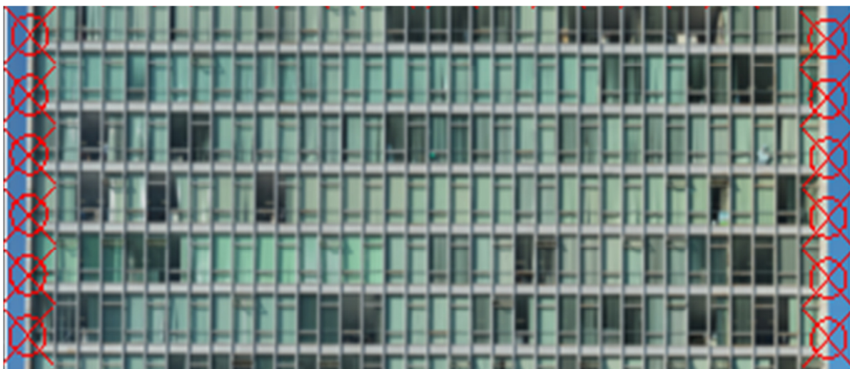
Figura 5. 31 - Pontos de controle identificados e marcados sobre parte da imagem panorâmica da fachada Sul do Anexo I da Câmara dos Deputados
