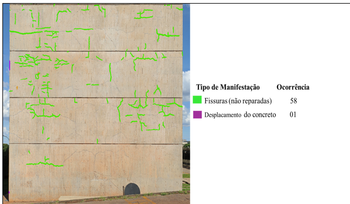
Figura 5. 63 - Mapeamento da posição 1 da fachada Oeste do edifício Anexo IV
