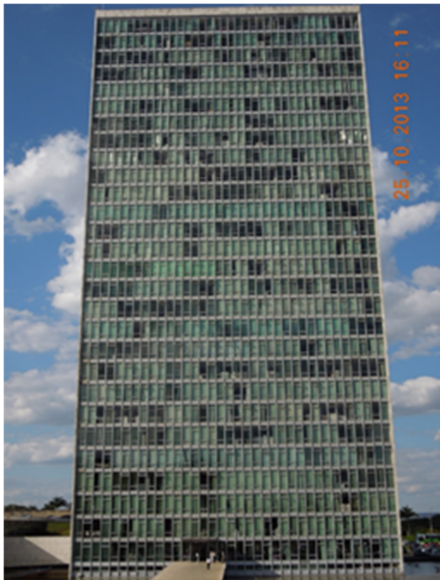
Figura 5. 38 – Imagem panorâmica da fachada Sul da torre do Anexo I da Câmara dos Deputados
