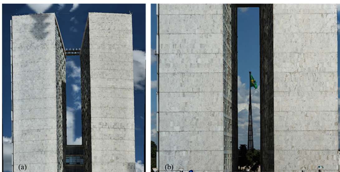
Figura 5. 33 – Etapas das tomadas fotográficas na Fachada Oeste do Anexo I da Câmara dos Deputados: (a) Etapa 2 e (b) Etapa 1
