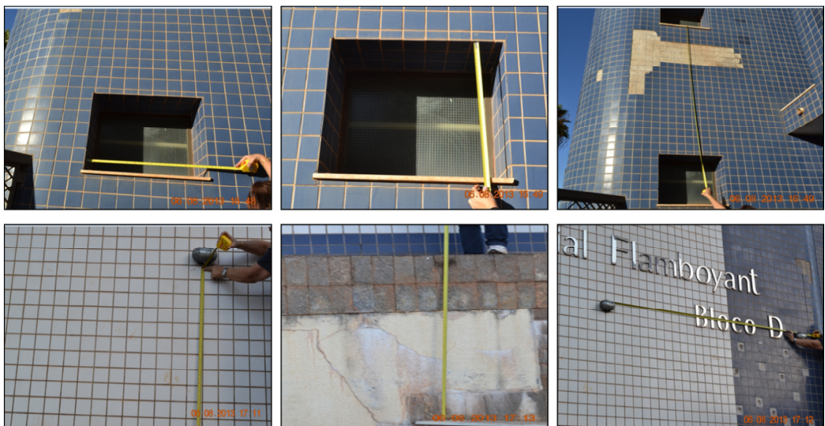
Figura 5. 7 - Medições obtidas no local o ajuste da imagem panorâmica em relação ao edifício
