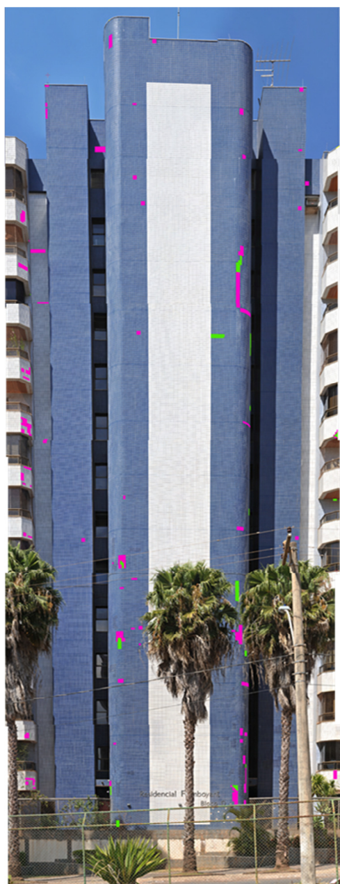
Figura 5. 15 – Mapeamento das manifestações patológicas visivelmente identificadas na fachada A (Posição Frontal)
