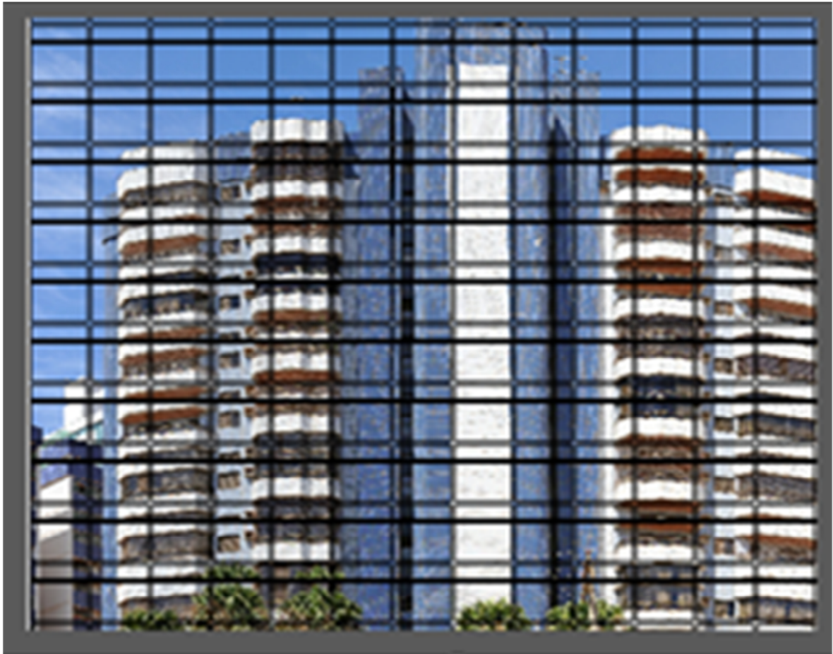
Figura 5. 5 - Mosaico de fotografias da posição frontal da fachada A do edifício residencial. (Fonte: tela do software Autopano Giga 3.0)
