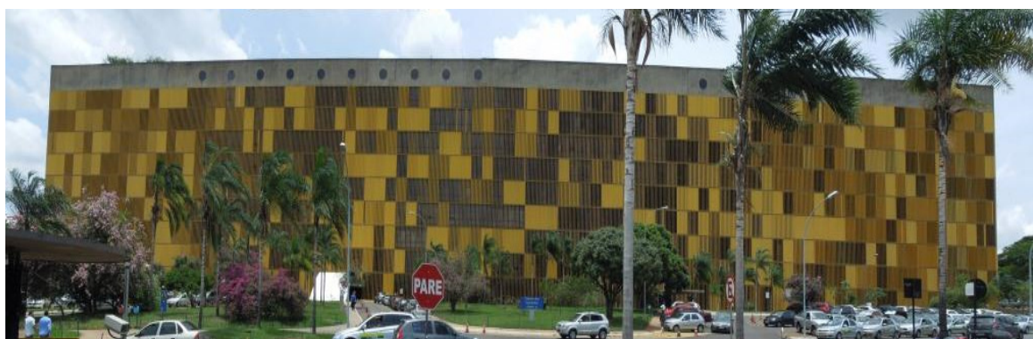
Figura 5. 48 – Imagem panorâmica retificada da fachada Norte do edifício Anexo IV da Câmara dos Deputados
