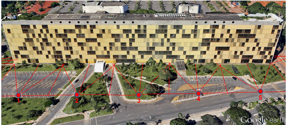
Figura 5. 54 - Mapeamento para posicionar os equipamentos na fachada Norte do edifício Anexo IV da Câmara dos Deputados (Fonte: Tela do serviço do Google Earth)
