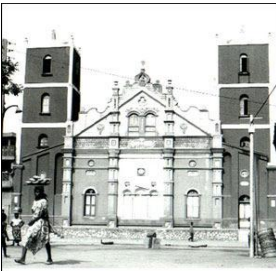
Uma das marcas da influência dos descendentes de brasileiros na arquitetura do Benin é a mesquita de Porto Novo. A construção acima é um típico exemplar da arquitetura colonial brasileira. Foto: Milton Guran
