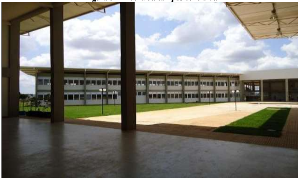
Figura 3 – A obra da campus concluída
