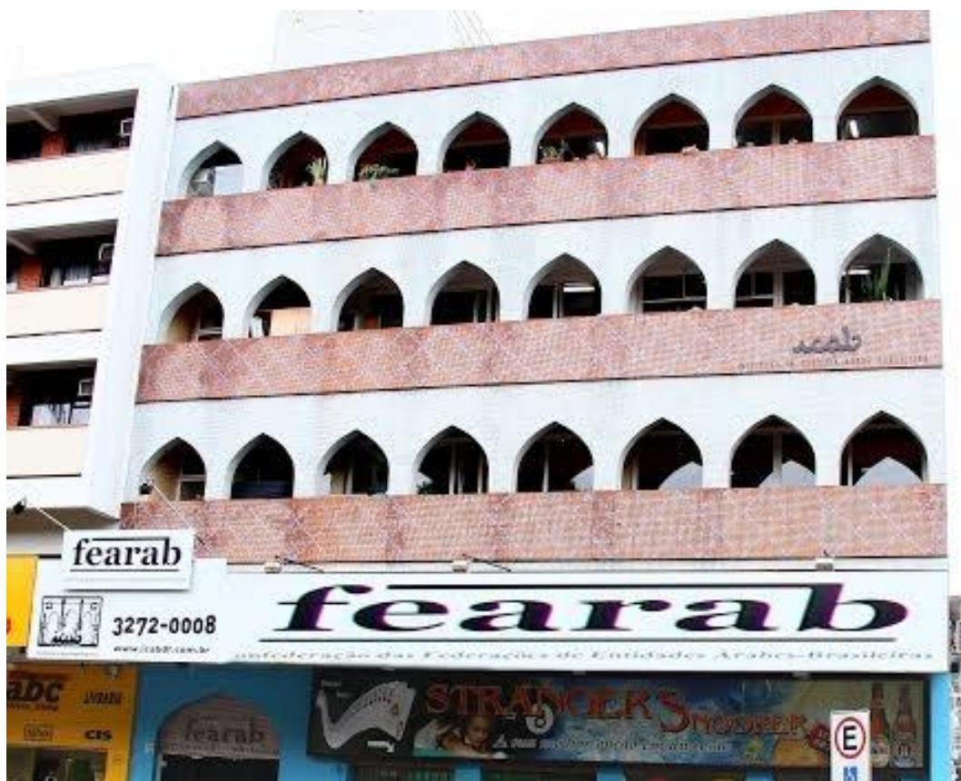
Figura 27 – Fachada do edifício onde está localizado o Instituto de Cultura Árabe Brasileira em Brasília – DF
