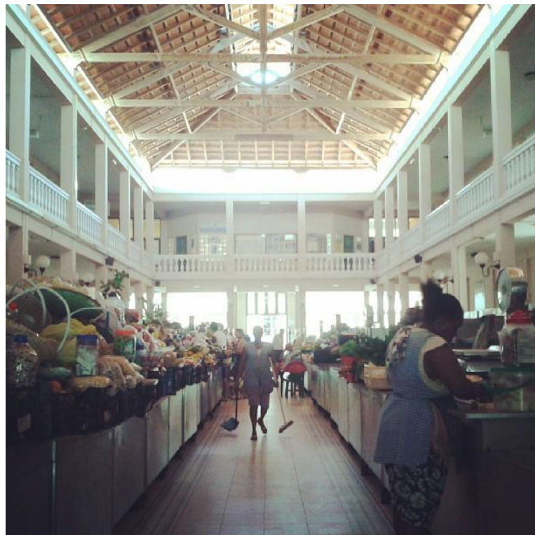
Fig. 3 – Parte interna do Mercado Municipal do Mindelo, localizado na morada . FONTE: Acervo do autor.
