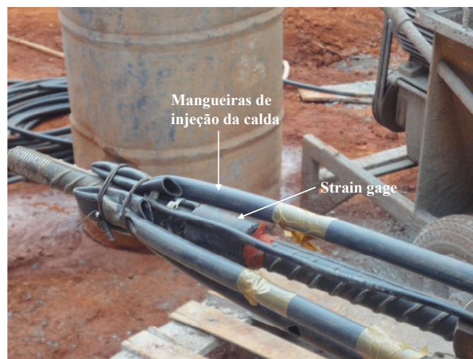
Figura 3.24: Grupo instrumentado na obra sob análise
