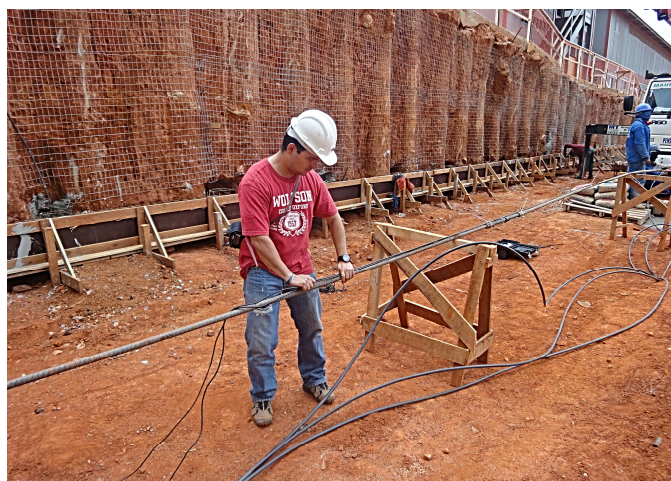
Figura 3.22: Foto de instalação da primeira linha do grampos
