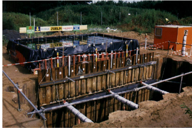
Figura 2.9: Configuração do ensaio a escala real de uma escavação em areia fina (von Wolffersdorff, 1994)
