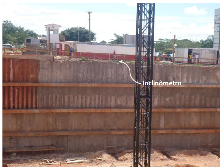
Figura 7.32: Foto panorâmica da contenção sob estudo depois da última etapa de escavação
