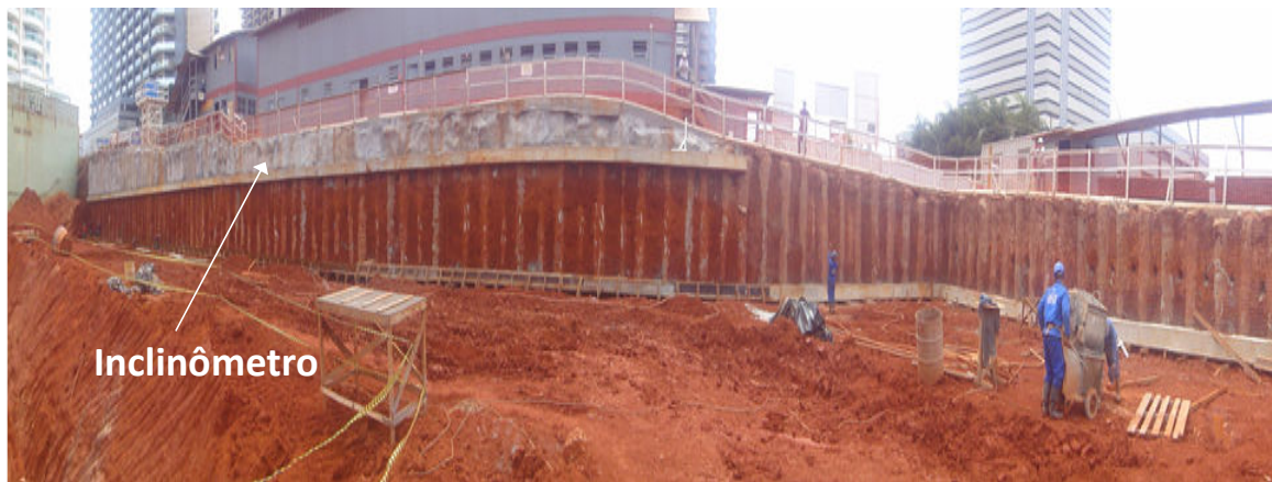
Figura 3.6: Foto panorâmica da seção instrumentada
