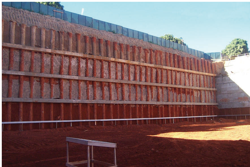
Figura 2.1: Estrutura de contenção tipo estaca justaposta (Medeiros, 2005)
