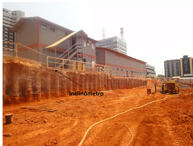
Figura 3.21: Foto de seção instrumentada para a primeira escavação
