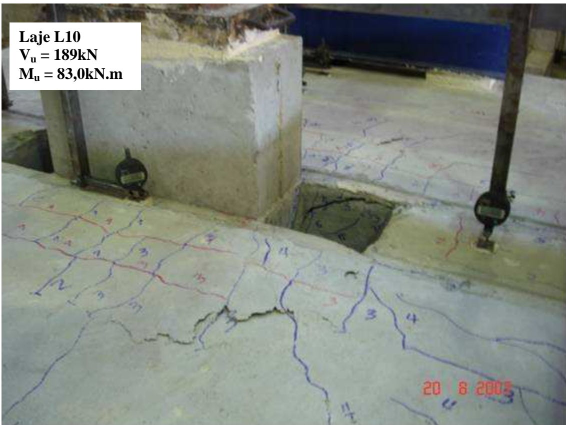
Figura 5.12 – Fotografia das superfícies de ruptura das lajes da Série 2
