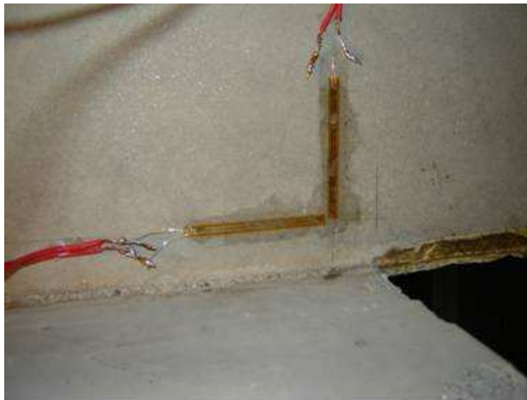
Figura 3.59 – Extensômetros de concreto colados
