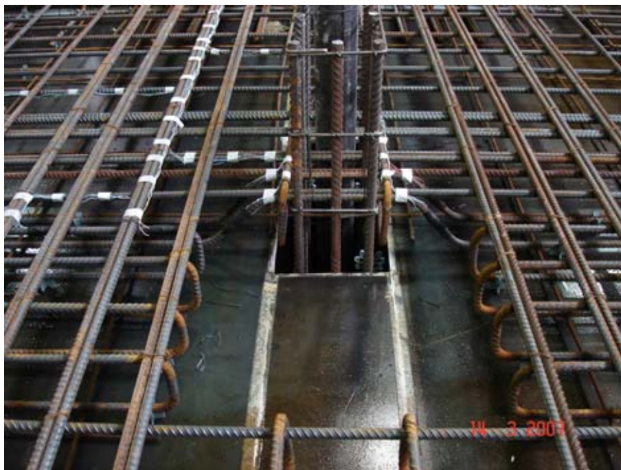
Figura 3.20 – Fotografia da armadura de cisalhamento da laje L6
