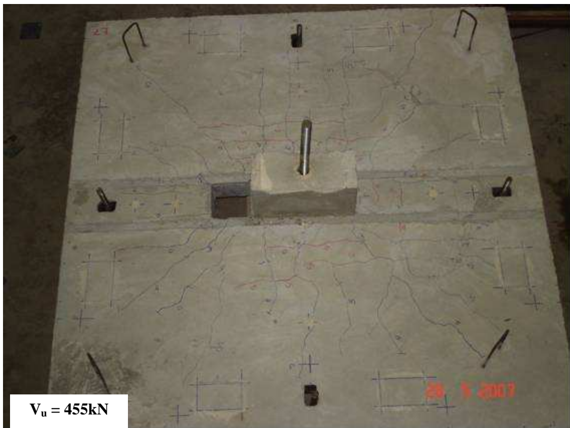
Figura 4.8 – Fissuração na laje L7
