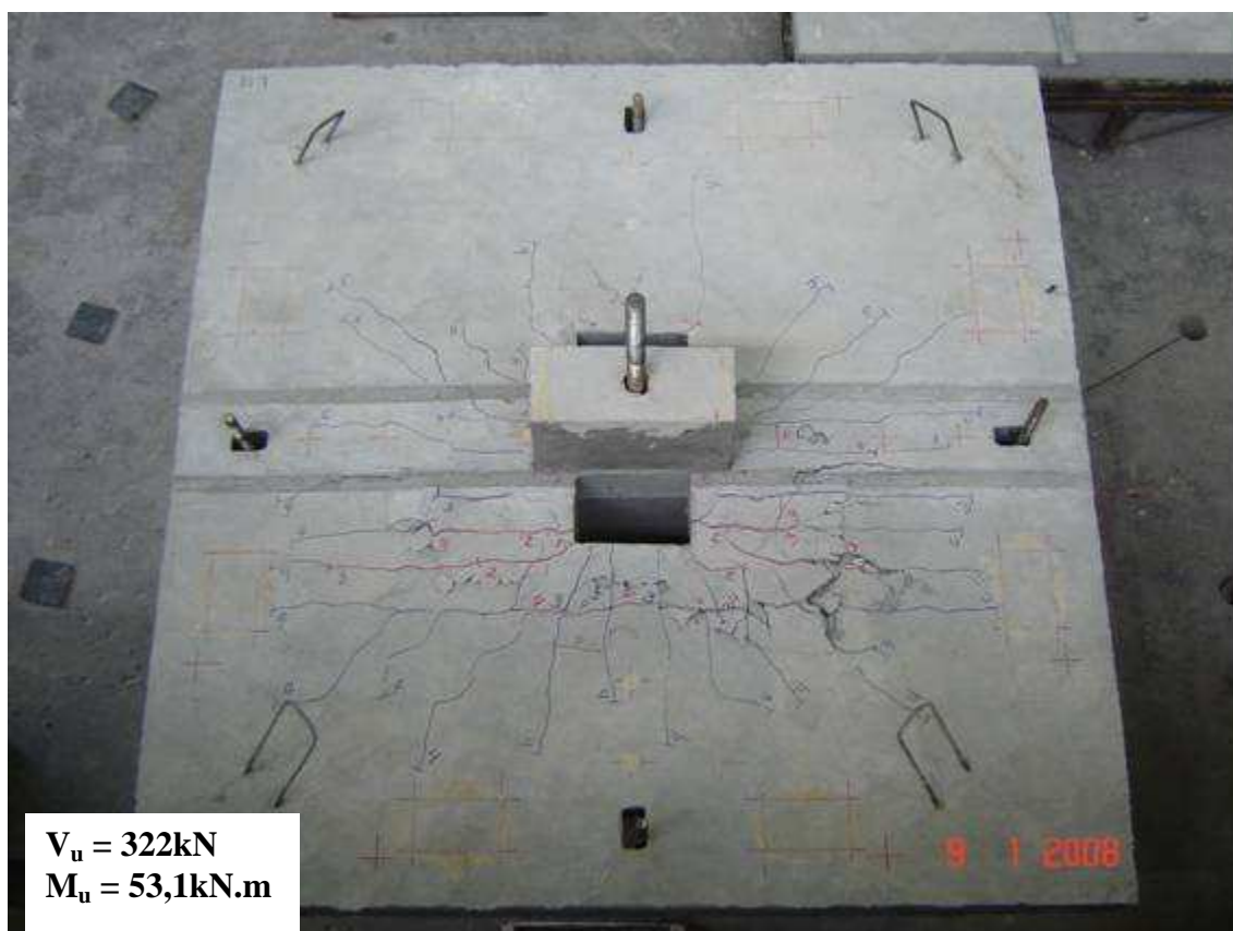
Figura 5.10 – Fissuração na laje L18
