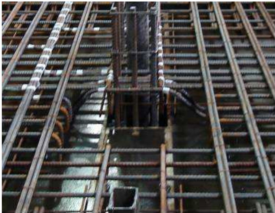
Figura 3.18 – Fotografia da armadura de cisalhamento da laje L5
