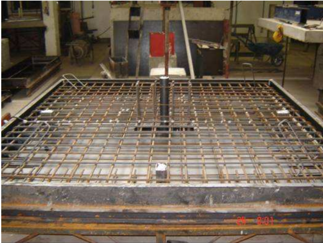
Figura 3.32 – Fotografia das lajes L14 antes da moldagem
