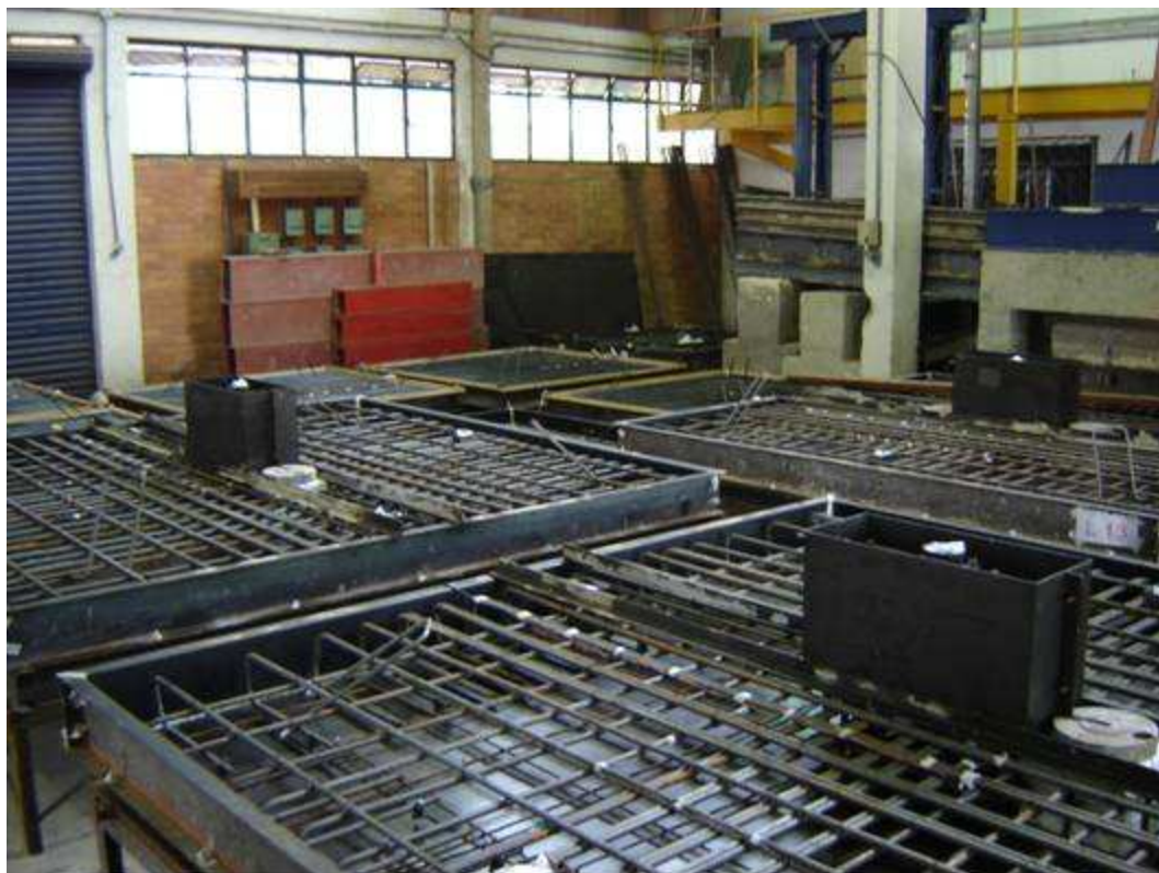
Figura 3.31 – Fotografia das lajes L11, L12 e L13 prontas para moldagem
