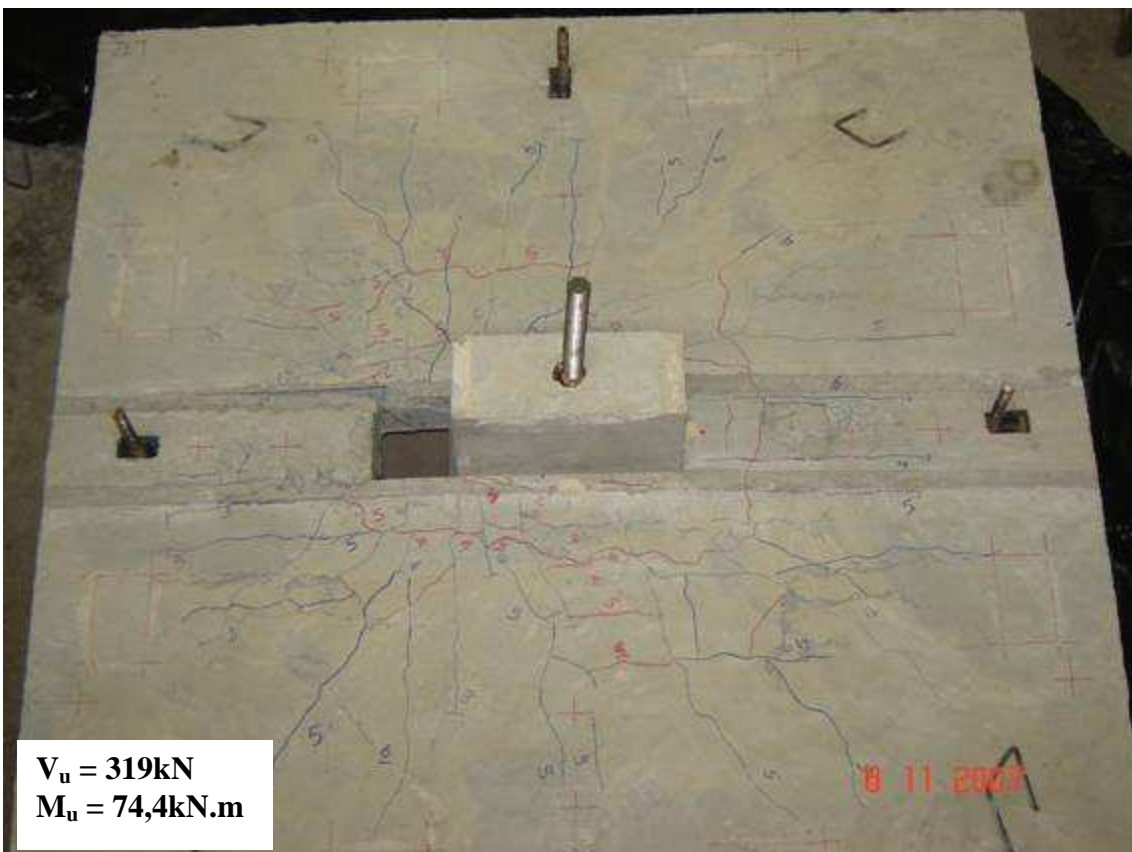
Figura 5.5 – Fissuração na laje L12
