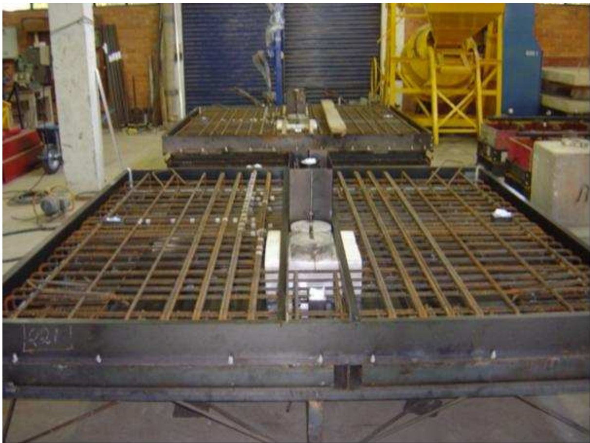
Figura 3.29 – Fotografia das lajes L3 e L4 prontas para moldagem
