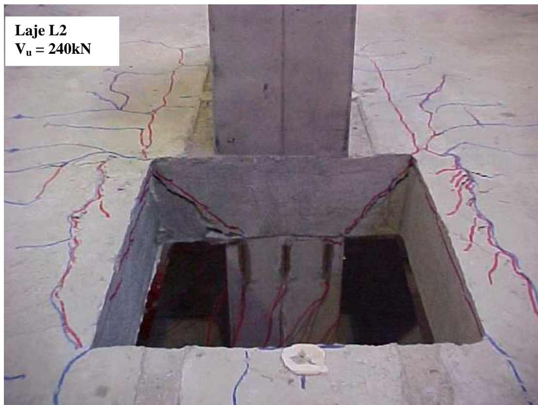
Figura 4.13 – Fotografia das superfícies de ruptura das lajes da Série 1
