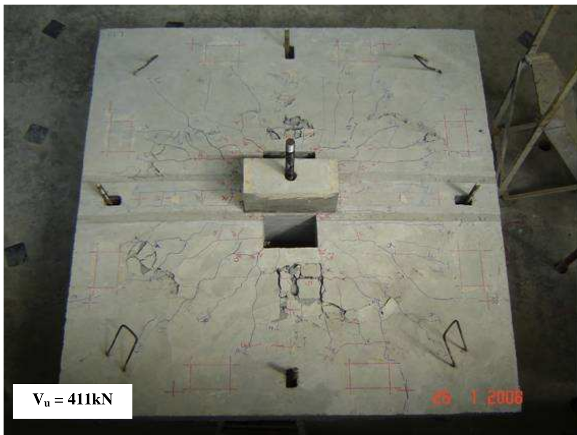
Figura 4.11 – Fissuração na laje L19
