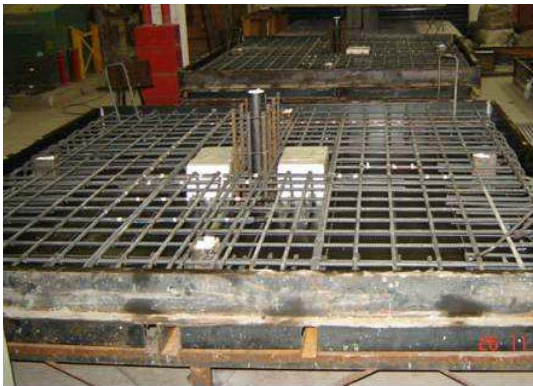
Figura 3.33 – Fotografia das lajes L17 e L18 antes da moldagem
