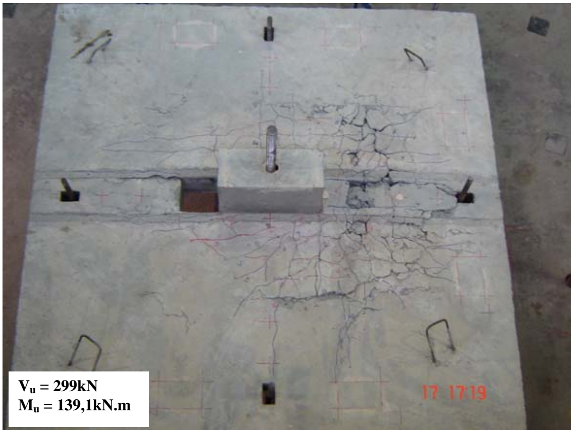
Figura 5.4 – Fissuração na laje L11
