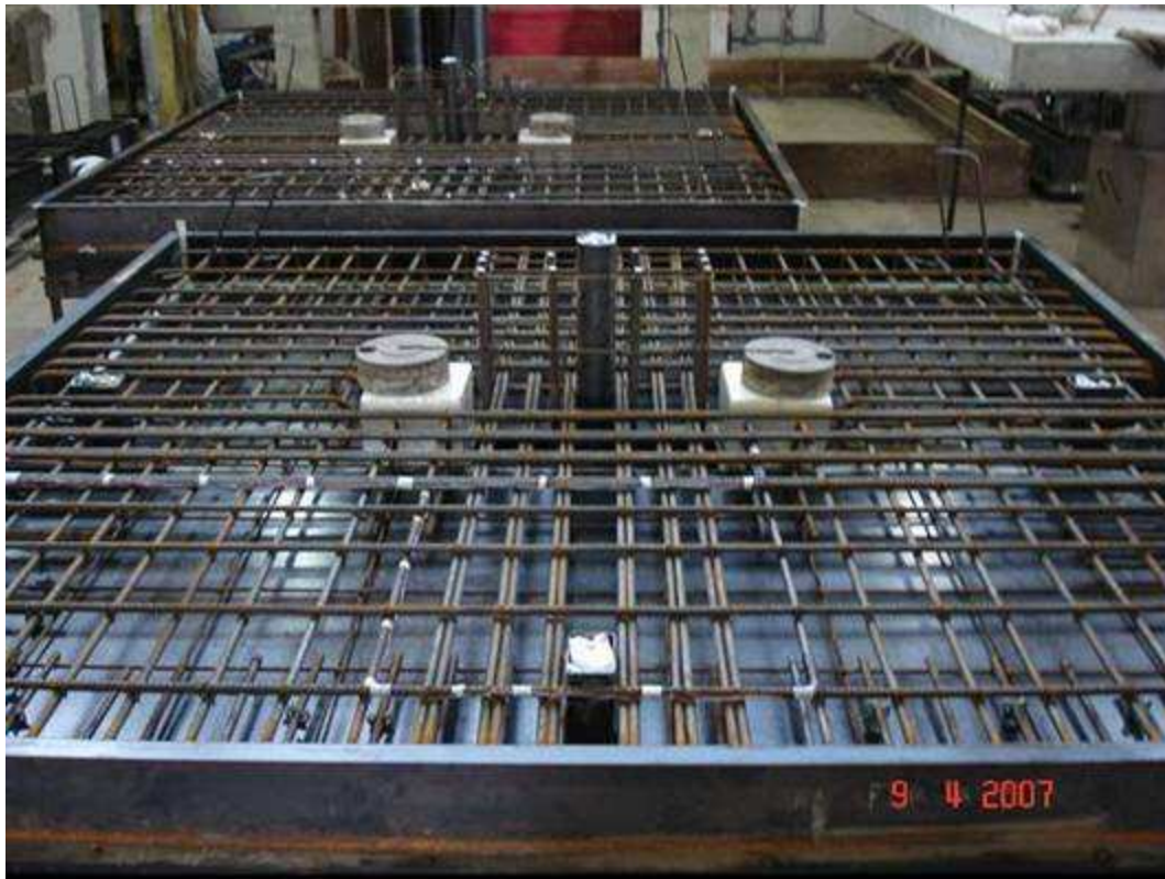
Figura 3.30 – Fotografia das lajes L9 e L10 antes da moldagem
