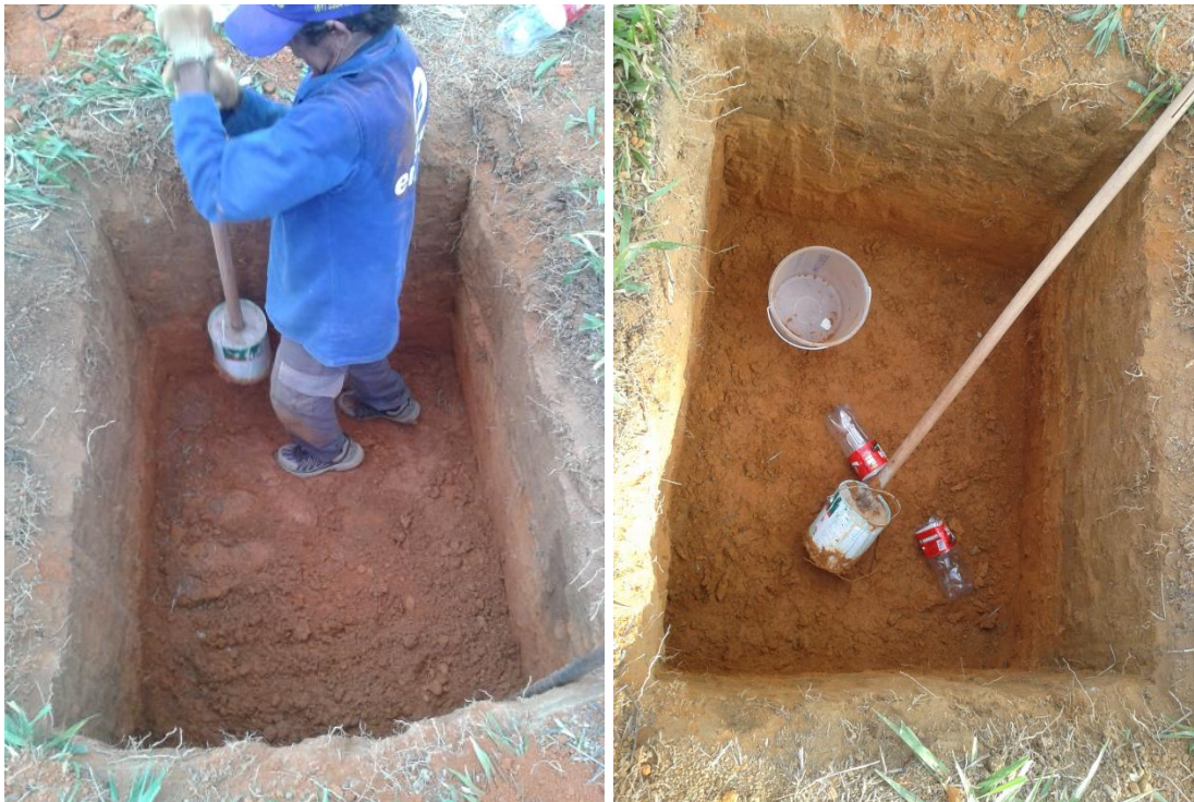
Figura 3.22 – Compactação das camadas de solo
