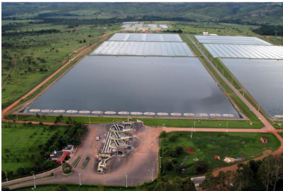
Figura 2.1 – ETE SAMAMBAIA (Fonte: CAESB, 2014).
