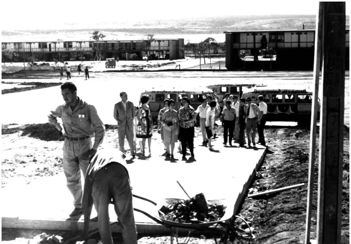
Figura 106 – Universidade em construção. Vista, em segundo plano, dos prédios da Oca I e Oca II, 1962. Fonte: Cedoc/UnB.
