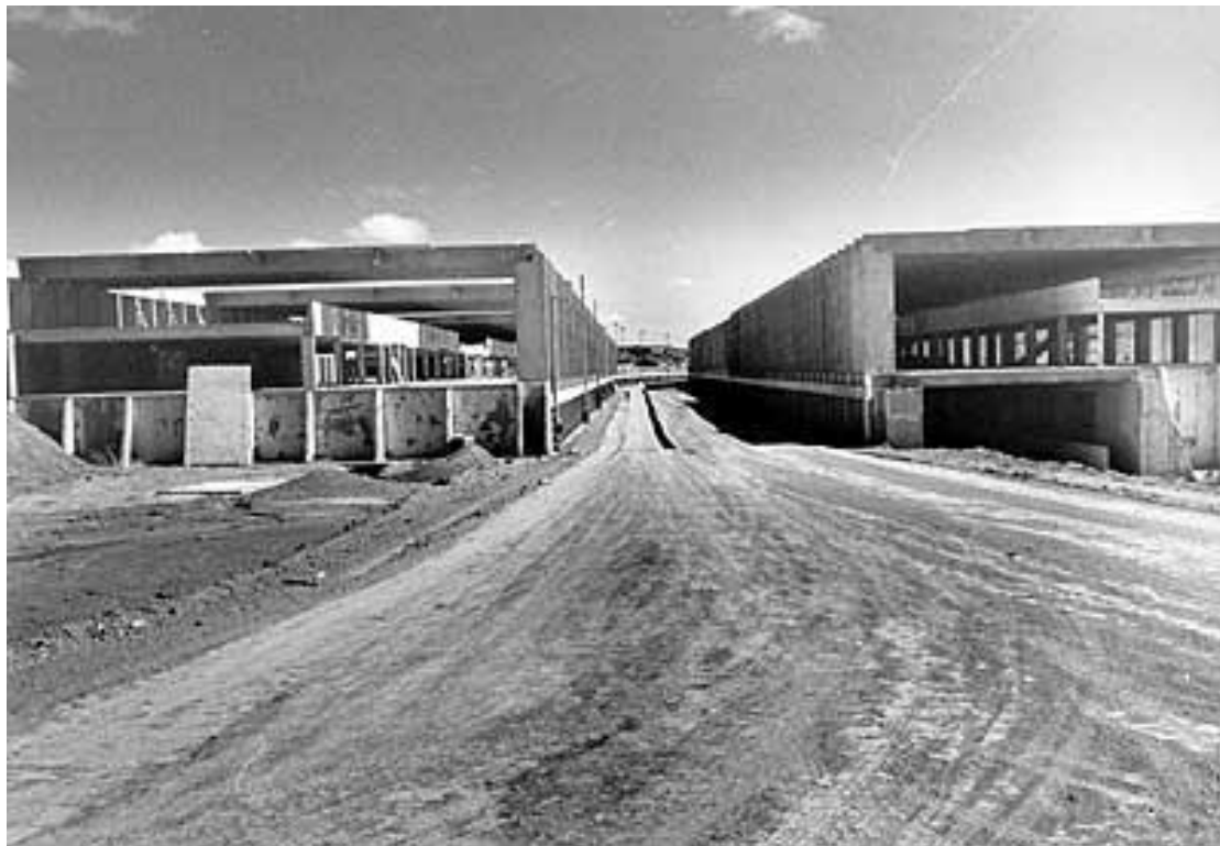
Figura 107 – Universidade em construção. Obras do ICC, 1963. Fonte: Cedoc/UnB.
