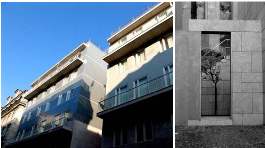
Terraços de Bragança - vista das fachadas e espaço de transição entre o edifício novo e o existente.
