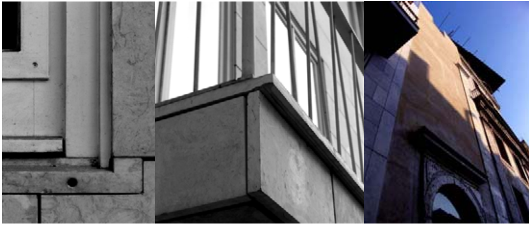
Terraços de Bragança - detalhe da janela, do terraço e vista da fachada exatamente na transição do edifício novo para o existente.
