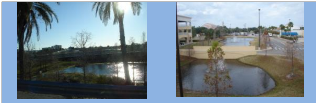
Figura 5.19 - Fotos de lagoas de retenção em Orlando – Flórida - EUA
