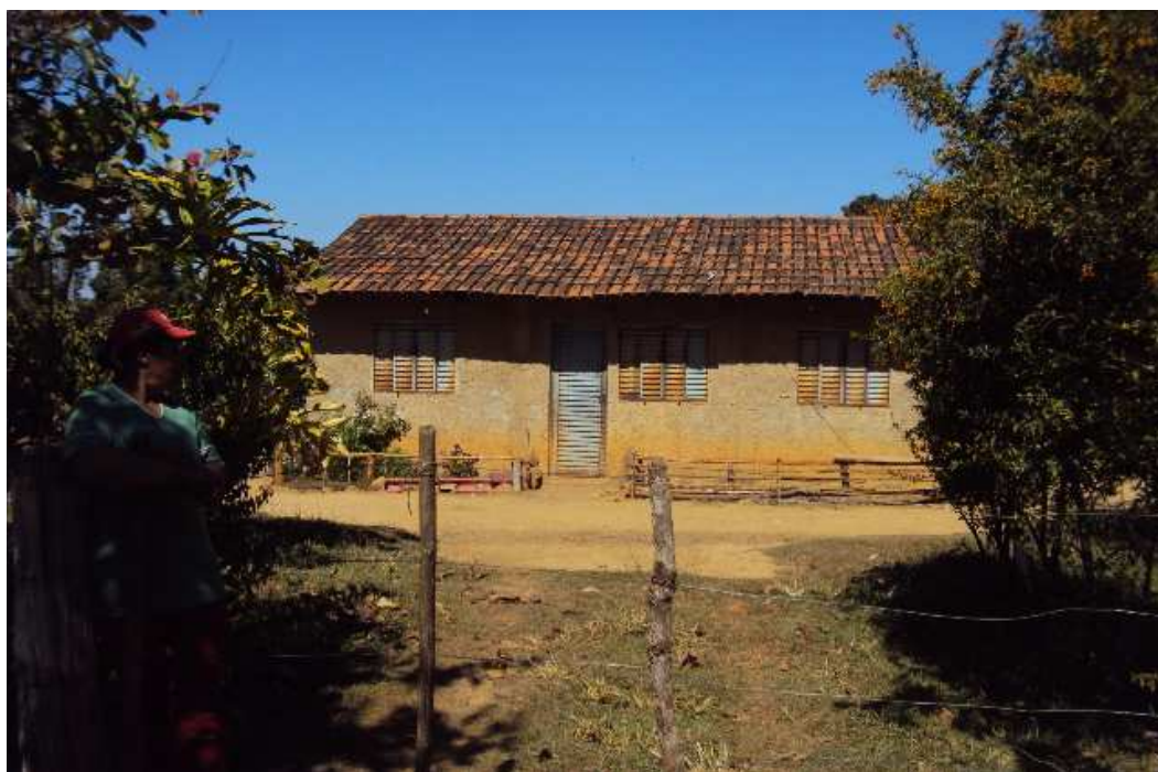
FIGURA 7 – Modelo e condições quase padrões de residência de moradores do assentamento Herbert de Souza, em Paracatu, MG. Para quem morou sob uma lona por meses, poder se abrigar sob um teto de telha já é um avanço. O escurecimento do telhado e a ferrugem de janelas e portas sugerem uma construção que remonta aos primeiros anos de assentamento; e ainda que o jardim com roseiras anule um pouco a aspereza do reboco das paredes externas, estas permitem cogitar um projeto de construção inacabado, talvez por falta de recursos ou para ser concluído quando estes estivessem mais abundantes, o que ainda não aconteceu.
