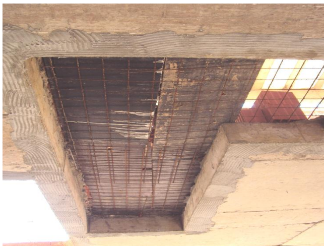
Figura 2.11 - Aplicação de chapisco industrializado no encontro da alvenaria com a laje
