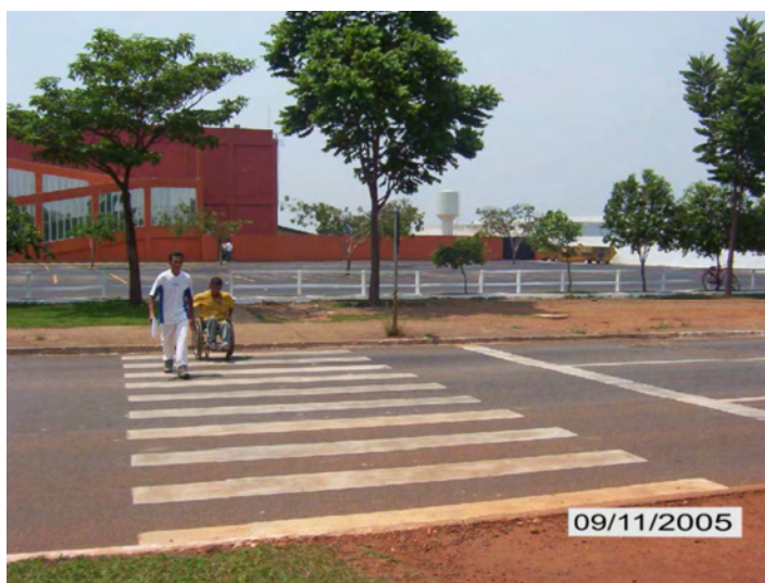
Figura 58: Faixas sem calçadas e rampas Av. LO-1. Fonte: ATTM – Assessoria de Planejamento.
