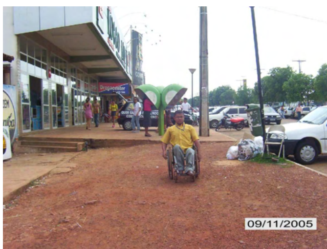
Figura 57: Calçadas sem pavimentação Av. JK. Fonte: ATTM – Assessoria de Planejamento.
