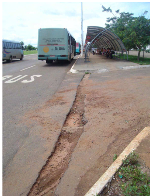
Figura 51: Estação Apinajé, Av. Theotônio Segurado Fonte: ATTM – Assessoria de Planejamento
