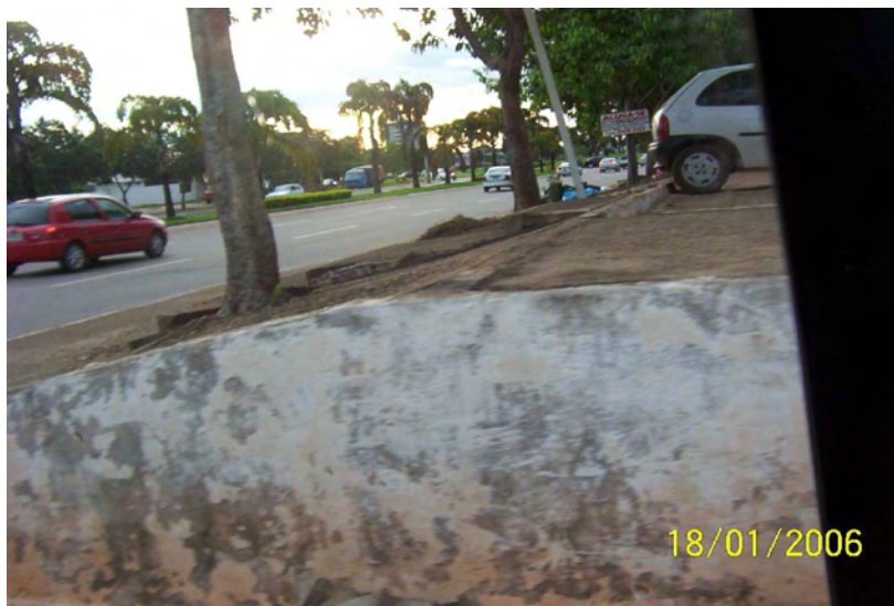
Figura 45: Desnível das calçadas- 104 Sul. Fonte: ATTM – Assessoria de Planejamento
