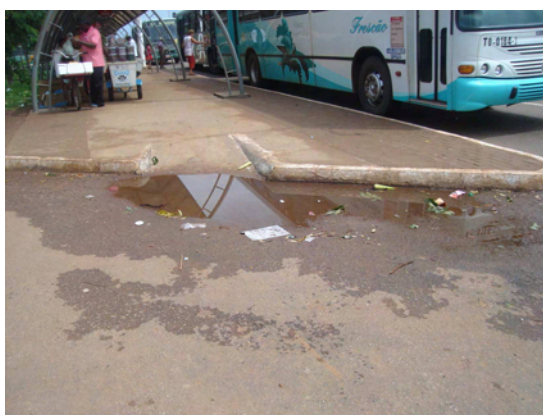
Figura 52: Estação Apinajé Av. Theotônio Segurado Fonte: ATTM – Assessoria de Planejamento
