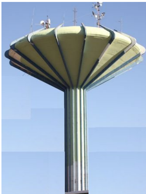
Figura 6 - Caixa d'água da Ceilândia 22 Fonte: Internet 23
