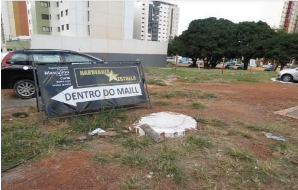
Figura 13 – Acúmulo de mato e placas de publicidade.
