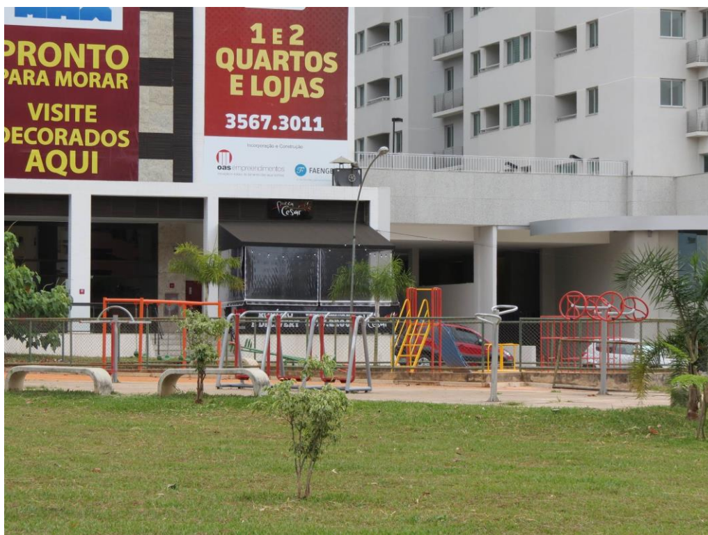
Figura 22 – Vista de uma das praças de Águas Claras.
