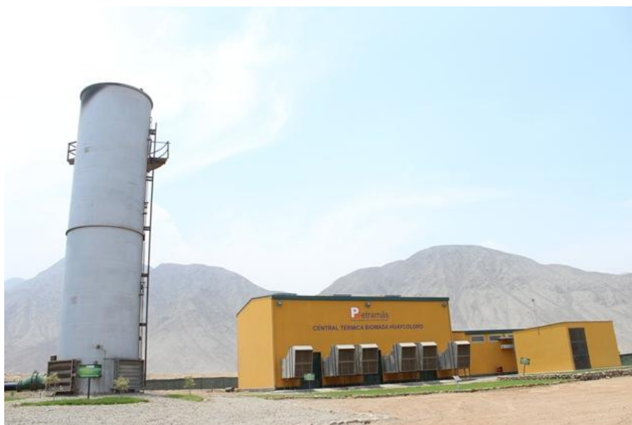
Figura 2.3 - Planta elétrica para queima de biogás para gerar energia elétrica
