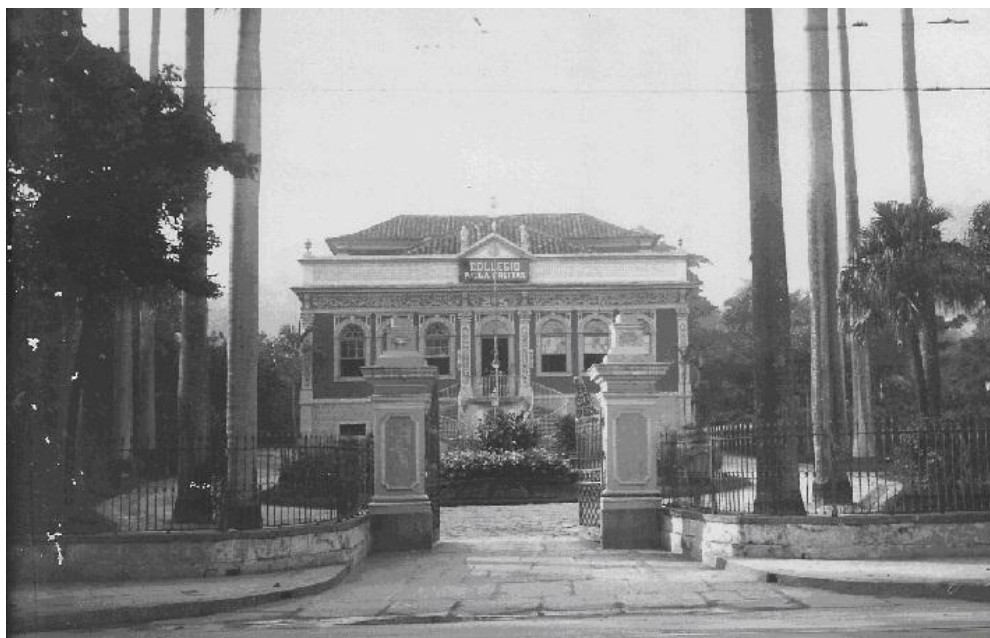
Figura 45- Colégio Paula Freitas (1892). Prédio tradicional que pertenceu ao Barão do Rosário, numa ampla área na Rua Hadoock Lobo no bairro da Tijuca, RJ.
