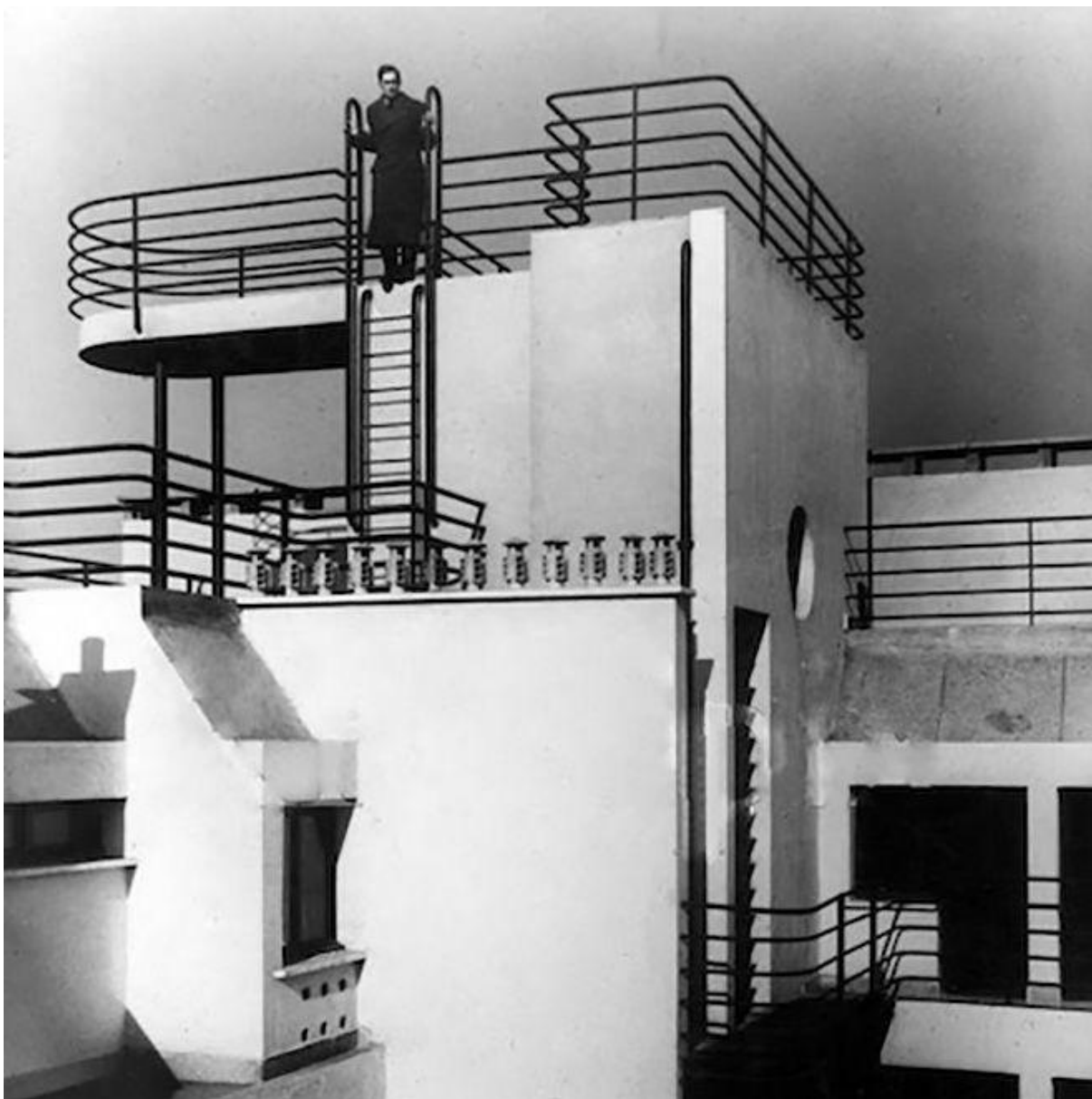
Figura 127 - Vista da cobertura do edifício da 25 Avenue de Versailles (1928-1931).
