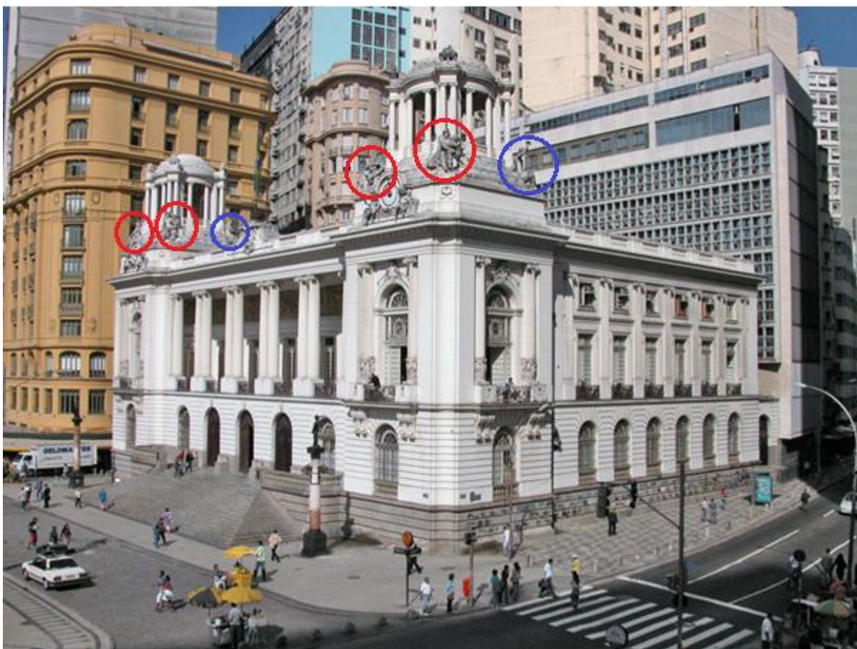
Figura 25- Palácio Pedro Ernesto. Rio de Janeiro, Cinelândia.
