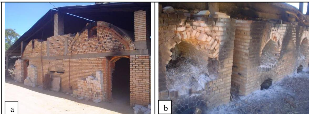
Figura 4.5: a- Vista frontal de um forno e b – vista lateral, mostrando a fornalha para abastecimento de lenha.
