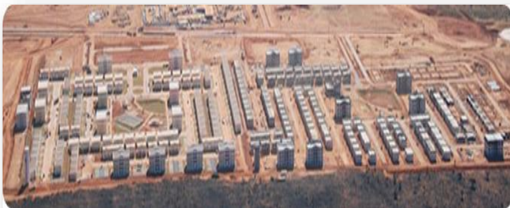
Figura 21 - Andamento das obras do Jardins Mangueiral
