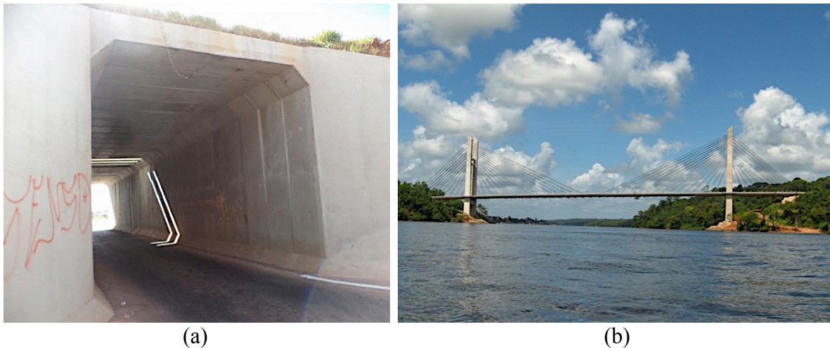
Figura 2.2 - Sistemas estruturais utilizados nos projetos de OAEs. (a) PI celular na BR-060/GO; (b) Ponte estaiada sobre o rio Oiapoque na fronteira Brasil-Guiana Francesa BR-156/AP
