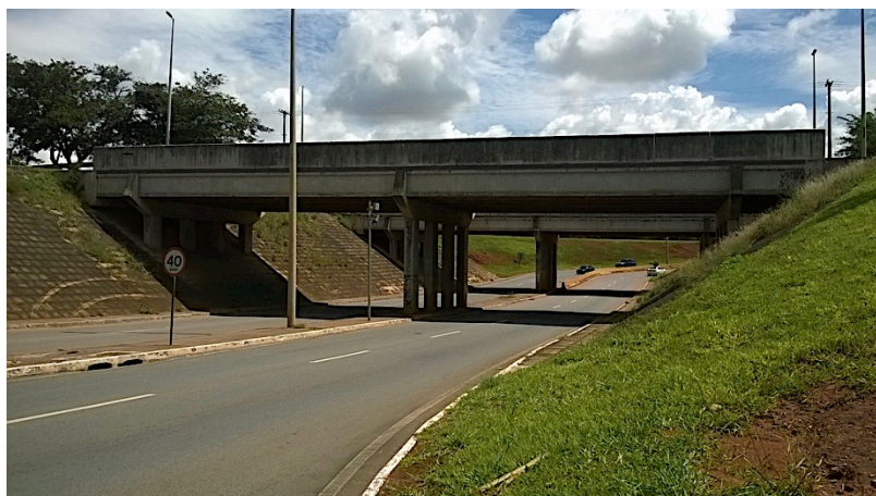
Figura 6.22 - Vista lateral da OAE-14, superestrutura em vigas pré-moldadas em travessas de concreto.
