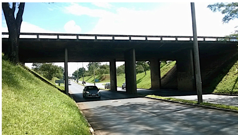
Figura 6.21 - Vista lateral da OAE-13, superestrutura em laje apoiada diretamente sobre pilares parede.
