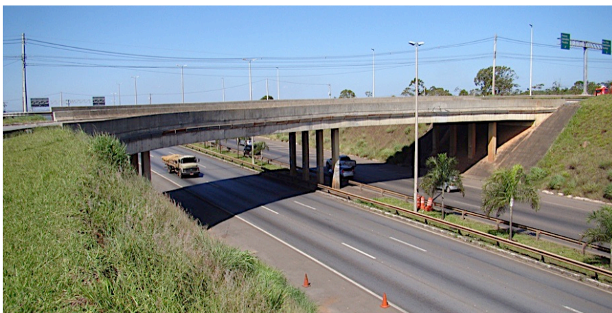
Figura 6.1 - Vista da OAE-01, viaduto em curva sobre a BR-450/DF.
