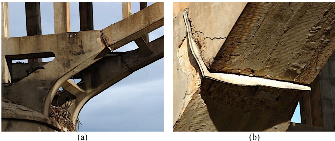
Figura 4.6 - Ponte em arco: (a) vista da ligação entre o arco triarticulado e o apoio; (b) detalhe da articulação de chumbo.
