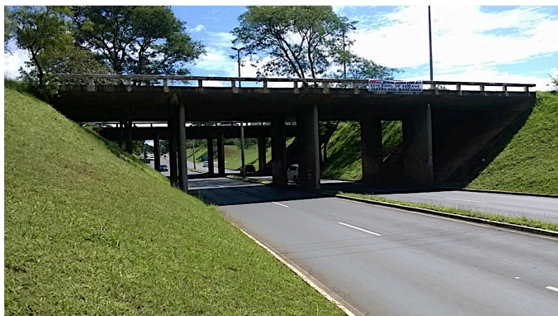
Figura 6.18 - Vista lateral da OAE-10, superestrutura em laje apoiada diretamente sobre pilares parede.
