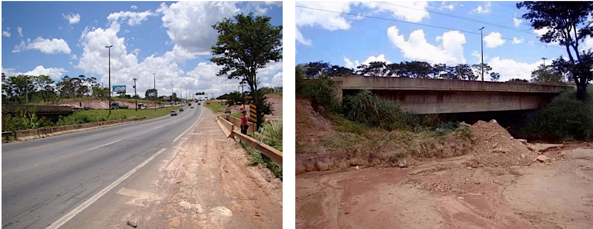
(a) (b) Figura 6.8 - OAE-02 (a) vista da entrada da ponte e (b) vista lateral.
