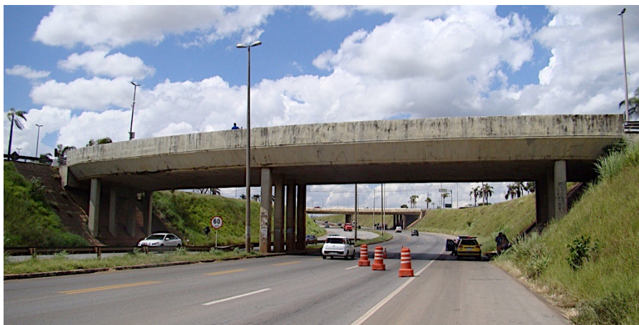
Figura 6.11 - Vista da OAE-04, viaduto em curva sobre a BR-450/DF.
