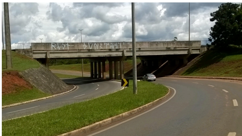
Figura 6.29 - Vista lateral da OAE-21, superestrutura em vigas pré-moldadas.
