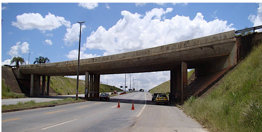
Figura 6.12 - Vista da OAE-05, viaduto em curva sobre a BR-450/DF
