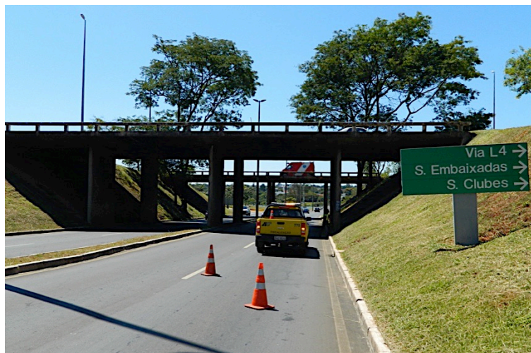
Figura 5.3 - Interdição de faixa de tráfego por Agentes de Trânsito do DER/DF.
