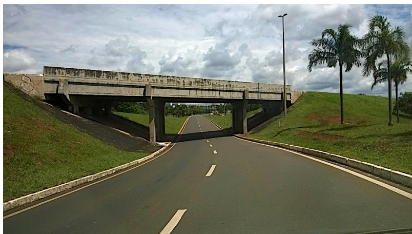
Figura 6.28 - Vista lateral da OAE-20, superestrutura em vigas pré-moldadas.
