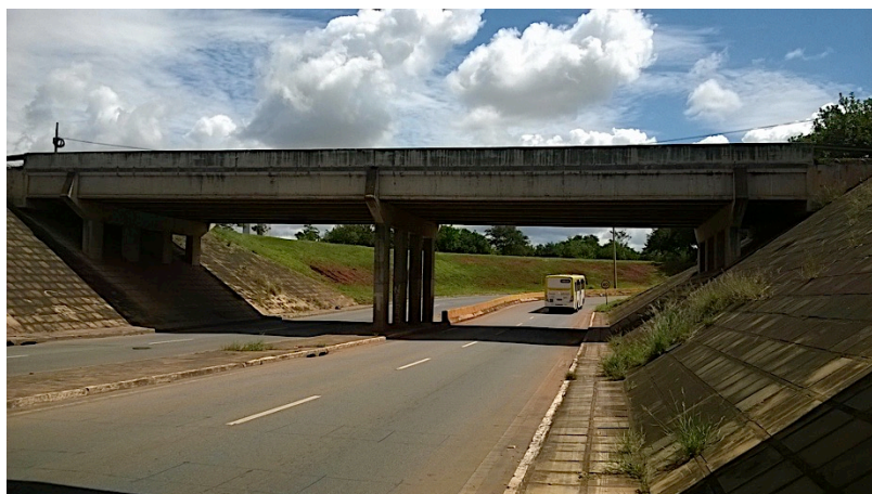
Figura 6.23 - Vista lateral da OAE-15, superestrutura em vigas pré-moldadas apoiadas em travessas de concreto.
