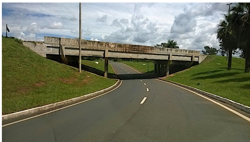
Figura 6.27 - Vista lateral da OAE-19, superestrutura em vigas pré-moldadas.
