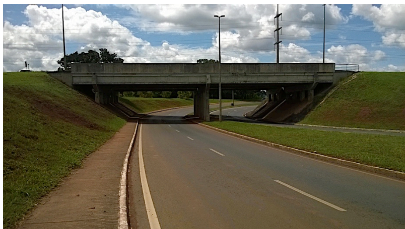
Figura 6.30 - Vista lateral da OAE-22, superestrutura em vigas pré-moldadas.
