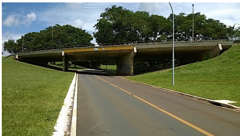
Figura 6.24 - Vista lateral da OAE-16, superestrutura em laje de concreto apoiada diretamente em pilares parede.
