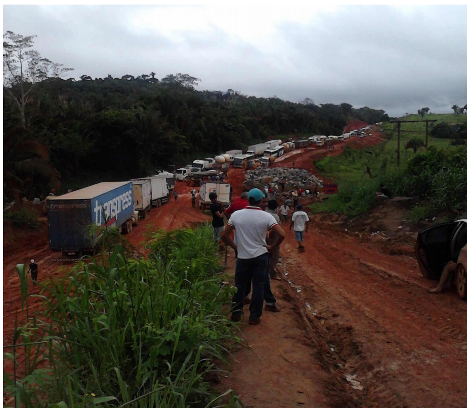
Atoleiro na Transamazônica, próximo a Pacajá-PA. Fevereiro de 2014. Foto: Raoni Giralдин
