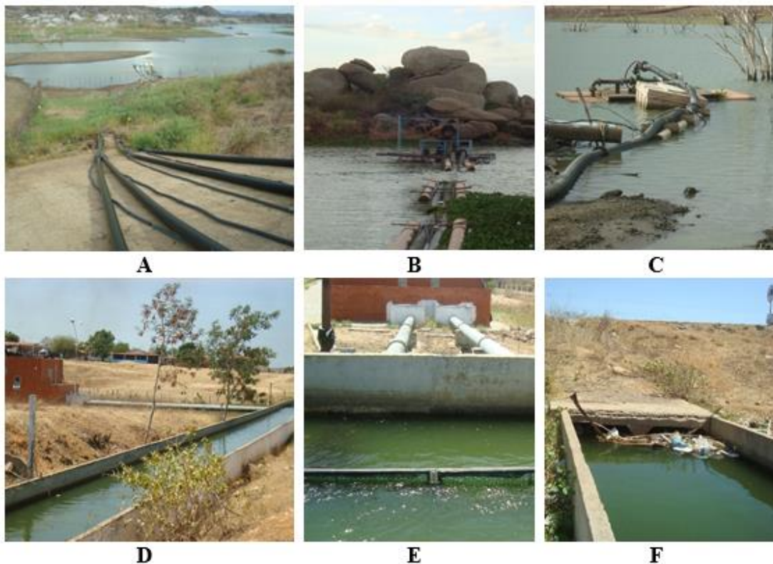
Figura B-5: Captações para abastecimento urbano de água no açude ARG: Sistema Integrado Médio Oeste (A), Sistema Integrado Serra de Santana (B), Sistema Isolado São Rafael (C) e Sistema Integrado Sertão Central Cabugi (Canal de Pataxó) (D, E e F).
