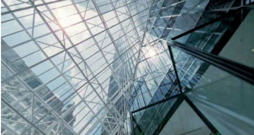
Visão do céu de dentro do suntuoso edifício onde Jack trabalha como arquiteto
