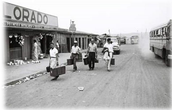
Figura 4: Chegada dos Candangos para trabalhar na construção da Capital. (Fonte: Arquivo Público do DF)
