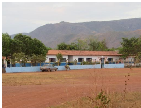
Figura 1 - Colégio Estadual Vale da Esperança (área externa).
