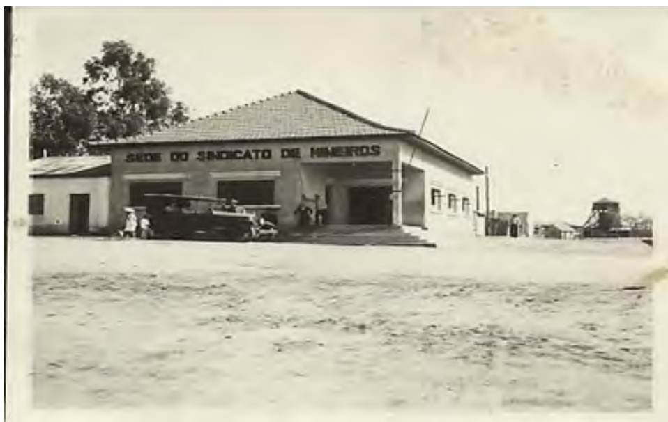
Figura 7 – Sede do Sindicato dos Mineiros de Arroio dos Ratos
