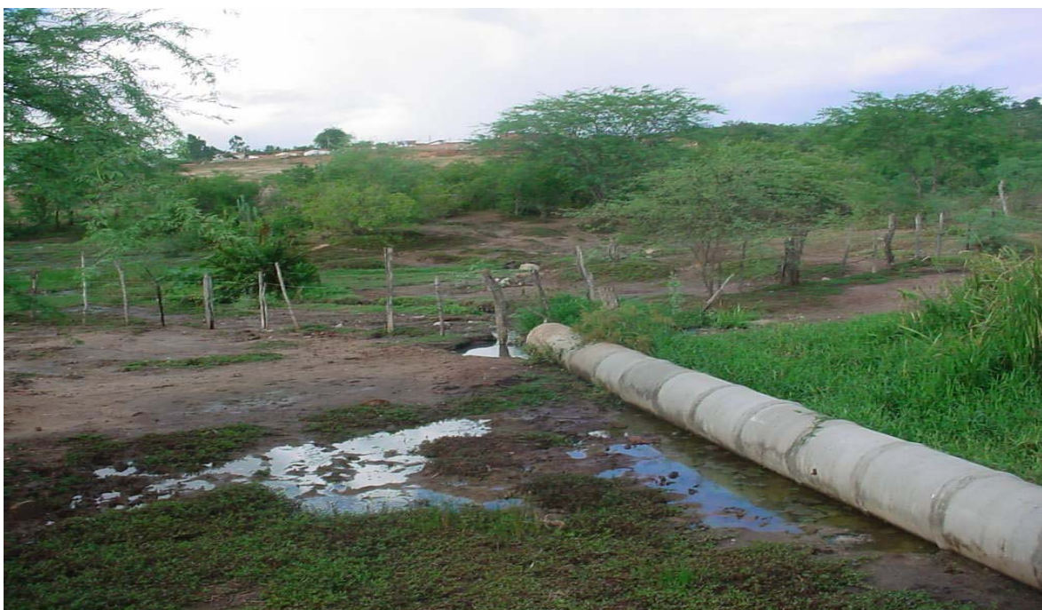
Figura 2: Esgoto lançado no riacho do Caititu, tributário do rio Piranhas, afluentes do rio Paraguaçu – Município de Itaberaba Fonte: Fundação Paraguaçu (2007).
