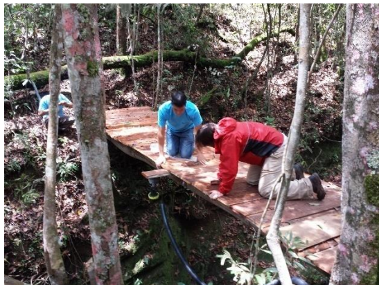
Figura 37: Instalação radar e ponte concluída - córrego Capetinga.
