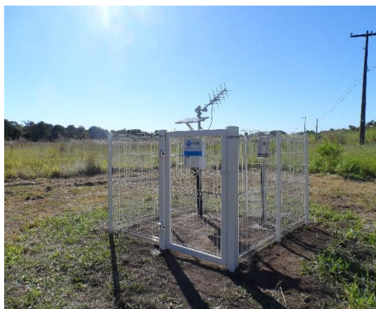
Figura 39: Estação FAL - UnB concluída.
