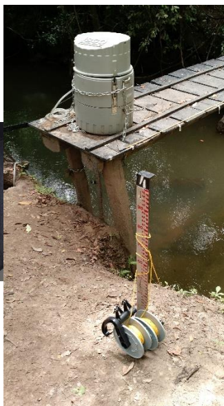
Figura 45: Amostrador instalado no Ribeirão do Gama.
