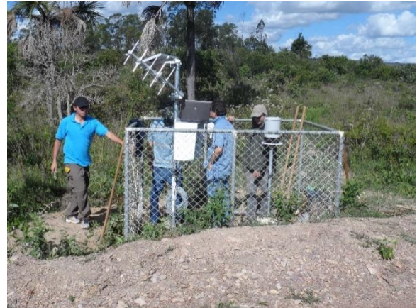
Figura 36: Técnicos da ANA auxiliando na instalação da estação córrego Taquara.
