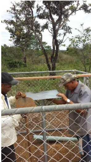
Figura 35: Instalação estação pluviométrica-fluviométrica - córrego Taquara.
