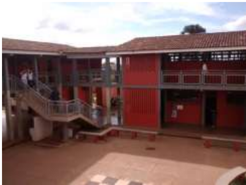
Figura 1: Vista da Escola
