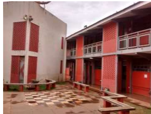
Figura 2: Vista da Escola
