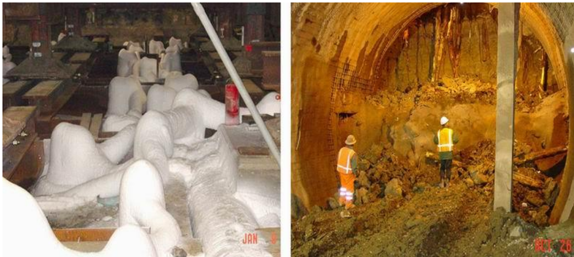
Figura 2.24. Processo executivo do túnel. (a) Tubo de congelamento vertical; (b) escavação com intervenção de estaca do edifício (Sauer, 2004).
