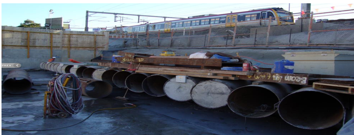
Figura 2.4. Tubos justapostos cravados executados abaixo de linhas ferroviárias (TunnelCorp, 2015).
