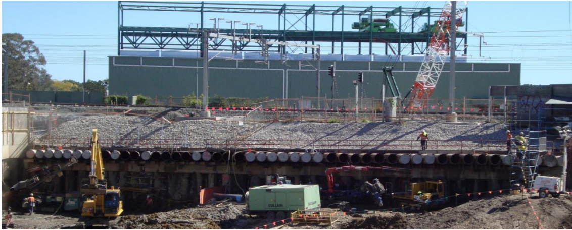
Figura 2.5. Intervenção nas extremidades das linhas ferroviárias (TunnelCorp, 2015).
