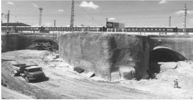
Figura 2.33. Emboque dos túneis sob a ferrovia (Koshima e Guatteri, 2006).
