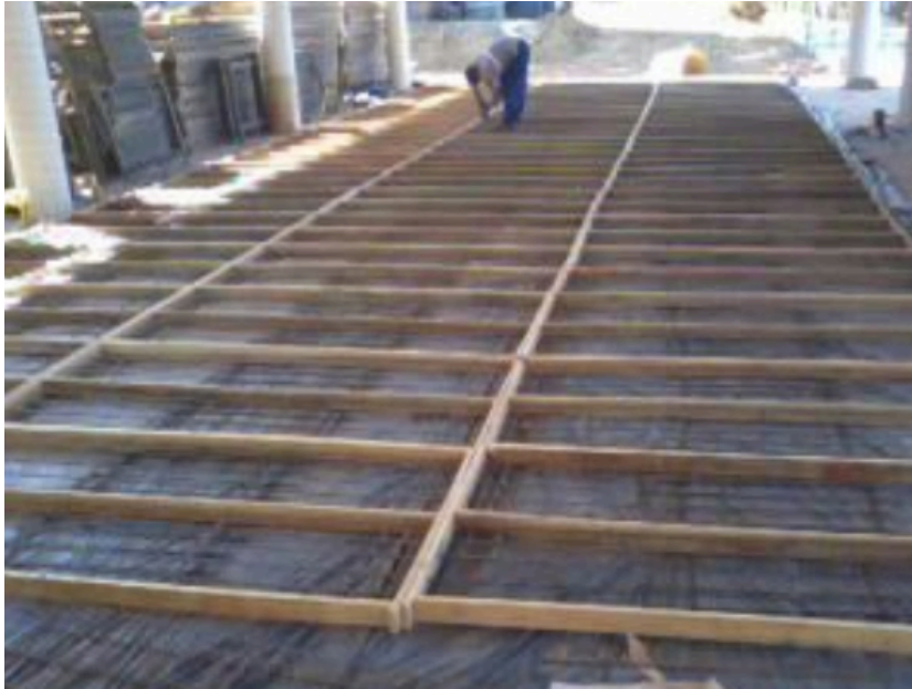
Figura 3.3 – Preparação das formas das lajes para a concretagem.
