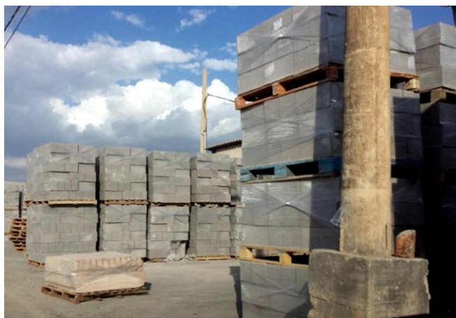
Figura 3.34 - Estocagem dos blocos de concreto protegidos com plástico.
