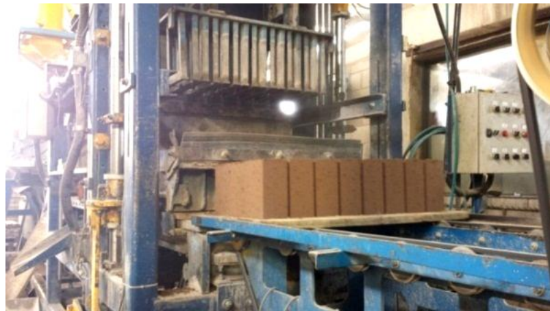
Figura 3.31 - Imagem onde pode ser visto o fim do processo de desforma dos blocos de concreto para dar início a um novo ciclo de produção.
