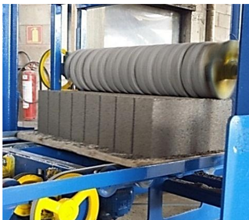
Figura 3.32 - Processo de acabamento final dos blocos com uso de rolo para retirada do excesso de material e regularização da sua superfície superior.
