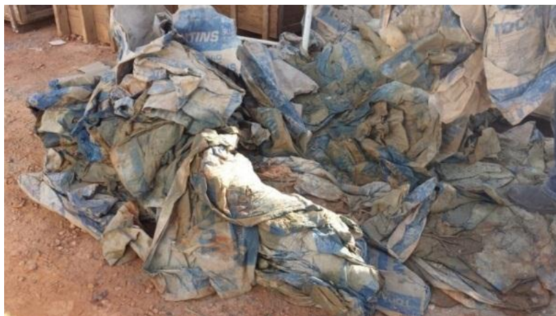
Figura 3.5- Armazenamento dos sacos de papel kraft utilizados como embalagens após sua utilização no canteiro de obra uma empresa em Brasília-DF.
