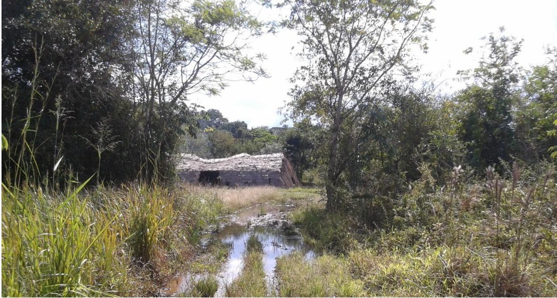
Figura 07. Registro fotográfico da Casa de Reza após dias de chuva em 6/3/2015 no Tekohá recuperado. Fonte: acervo pessoal, 2015.
