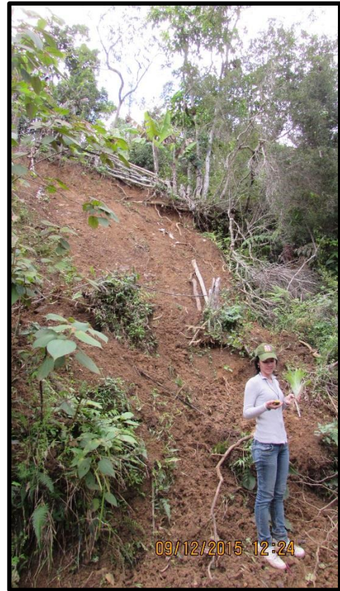
Figura 4.6 - Deslizamento de terra na estação 129 do percurso de campo apresentado na Fig. 4.3
