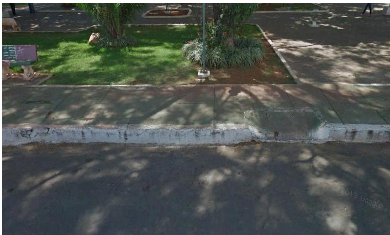
Fig. 4.73 – Calçada com rampa de acessibilidade, inacessível. Fonte: Google Earth. Acesso: março 2016
