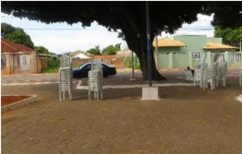
Fig. 4.75 – Uma das maiores áreas pavimentadas. Piso de blocos sextavados. Fonte: Fotos da autora, em 2014.
