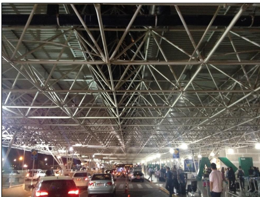
Figura 1.1 - Cobertura do aeroporto Juscelino Kubitschek, Brasília D.F
