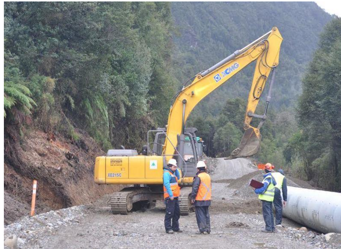
Figura 38 - Trecho norte da Ruta7 em obras. Foto: http://www.eldivisadero.cl/media/notis/30048_12.jpg . Acesso: março de 2016.
