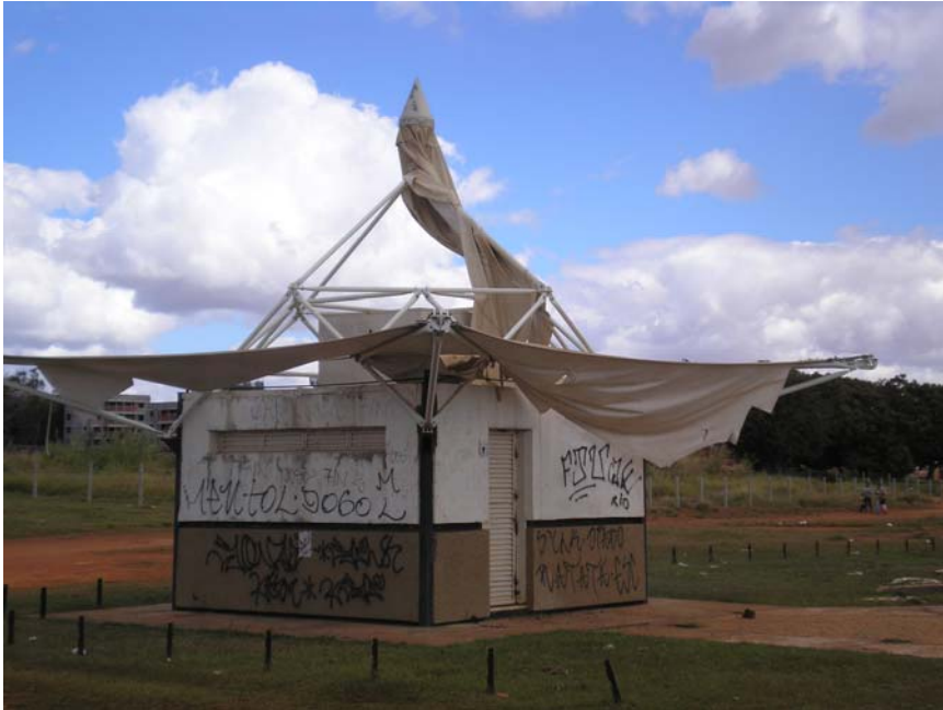
Figura 28. Pólo 3 – Complexo Brasília Palace, Imagem dos sanitários públicos degradados e em abandono, Julho de 2006.
