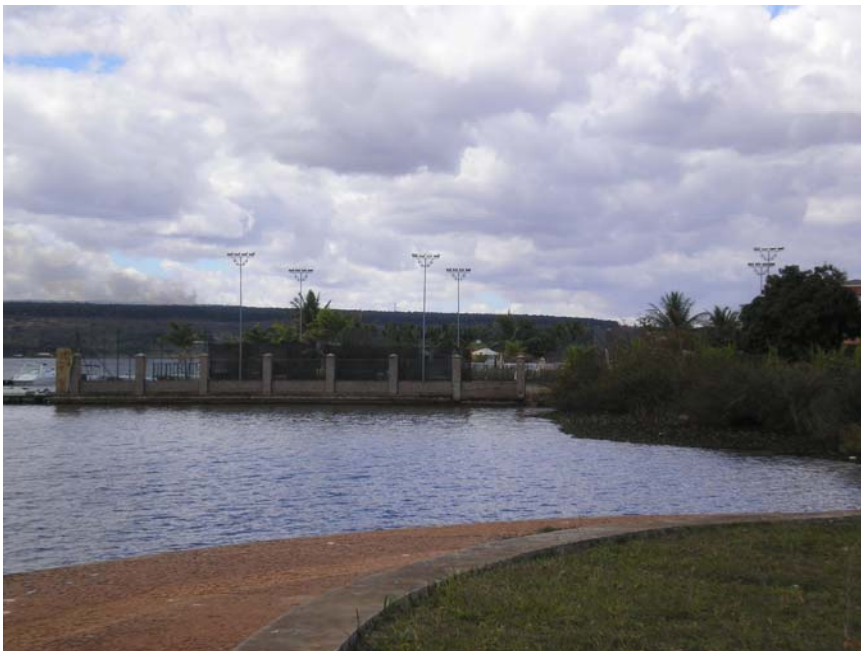
Figura 30. Pólo 3 – Complexo Brasília Palace. Invasão de área pública por apart-hotel (Lake Side) causando a interrupção do calçadão, Julho de 2006.
