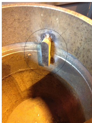
Figura 3.17. Configuração final de tubos internamente prontos para soldagem com os pontos de fixação.
