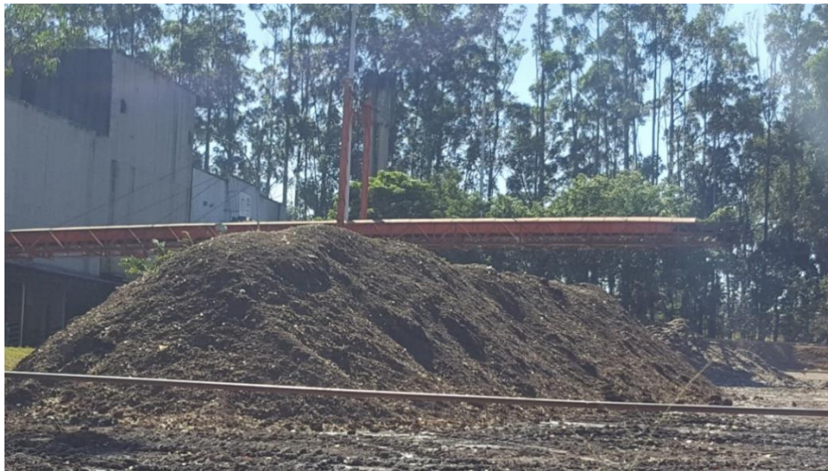
Figura 3 – Área externa de compostagem da Usina de Reciclagem e Compostagem de Resíduos Sólidos do “P” Sul, Ceilândia-DF.
