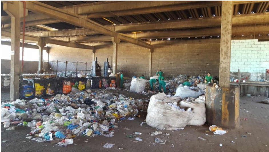
Figura 5 – Galpão de triagem de materiais reciclados da Usina de Reciclagem e Compostagem de Resíduos Sólidos do “P” Sul, Ceilândia-DF.
