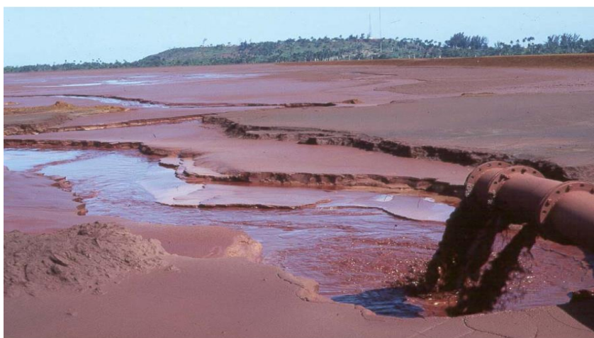
Figura 3.8 Ponto de deposição dos rejeitos do processo HPAL na barragem em Moa (Rodríguez, 2002).
