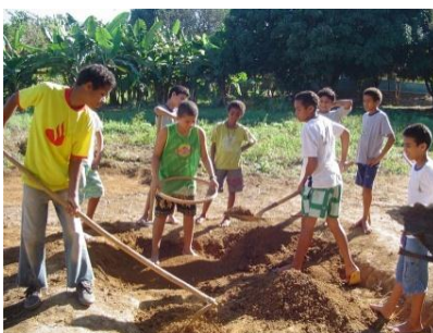
Figura 1: Construção do Museu. (Arquivo da Escola 3, 2008)
