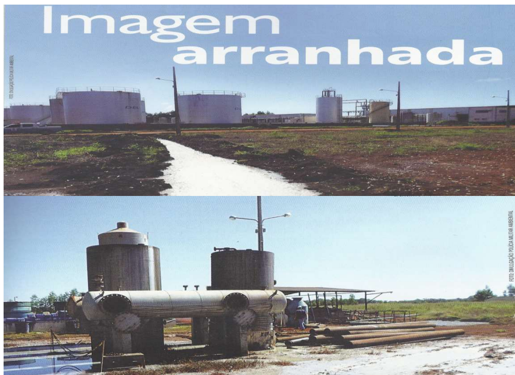
Fotos 3 e 4 – Imagens de vazamentos de efluentes de indústria de biodiesel.
